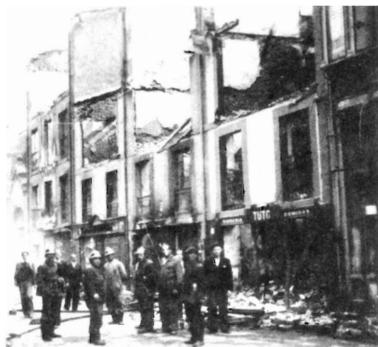
Fig. 2. Destrucciones bélicas en casas entre medianeras de la calle San Francisco.
