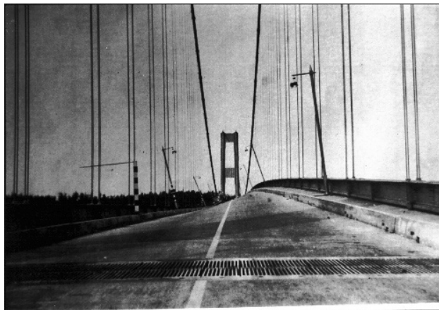
Figura 3.17: Oscilación del puente de Tacoma Narrows producto de un movimiento autoexcitado.
