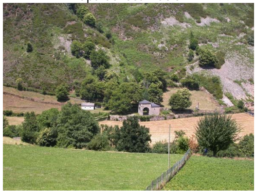
Vista general del depósito
