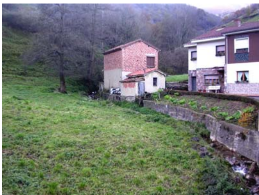
Vista general del depósito
