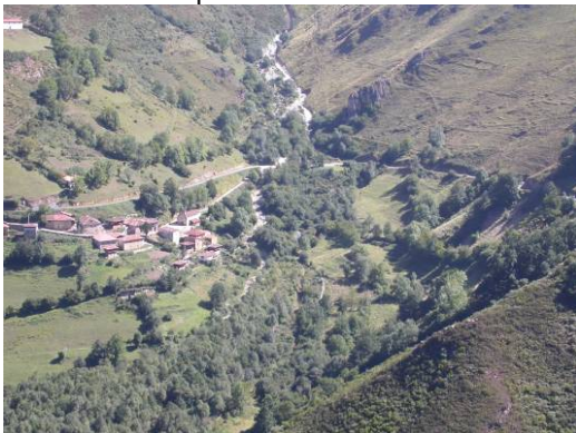
Vista general del depósito
