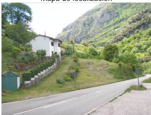
Vista general del depósito
