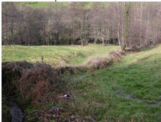
Vista general del depósito
