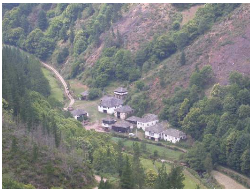
Vista general del depósito
