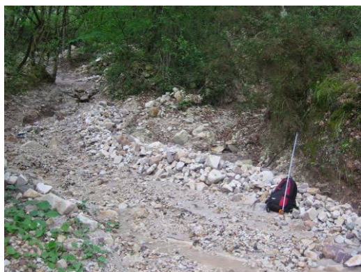
Levee lateral en canal torrencial
