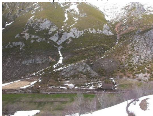
Vista general del depósito (derecha)
