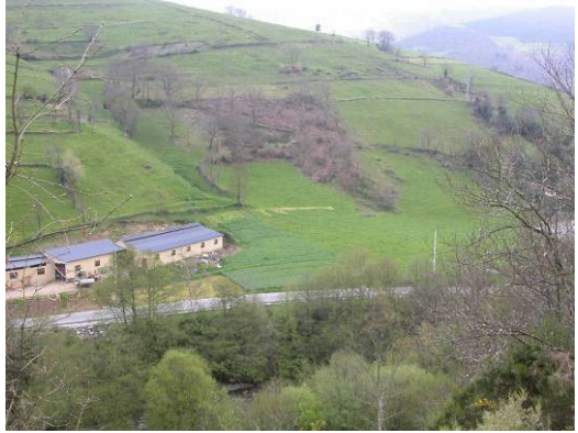
Vista general del depósito
