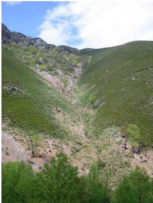
Vista general del sistema torrencial
