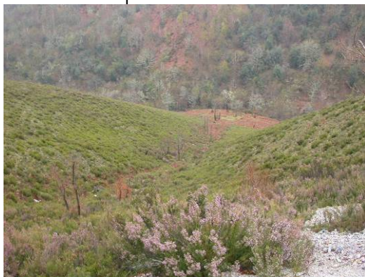
Vista general del depósito
