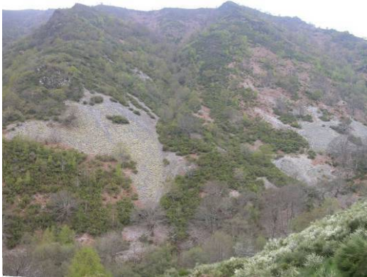
Aspecto general del sistema torrencial
