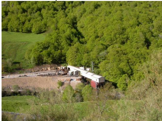
Vista general del depósito
