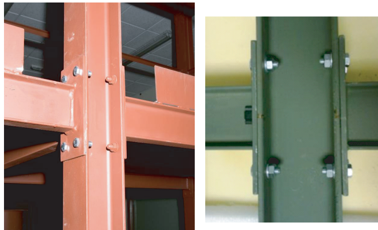
Figura 3.21: Fotografía de las uniones. Izquierda: Unión real en la estructura. Derecha: Unión construida en la Universidad de Zaragoza.
