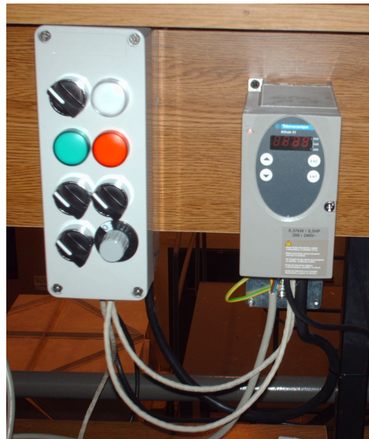
Figura 3.12: Foto del montaje del variador
