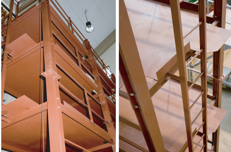
Figura 3.3: Elementos auxiliares. Izquierda: Barandillas. Derecha: Escalera.
