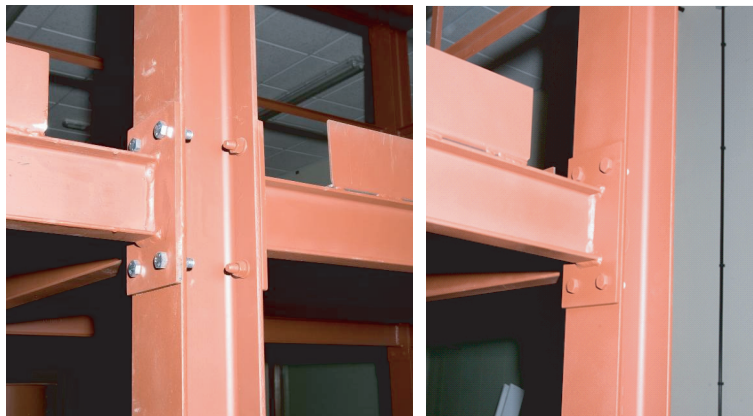
Figura 3.1: Uniones Viga-pilar en la estructura. Izquierda: Unión central. Derecha: Unión extrema.
