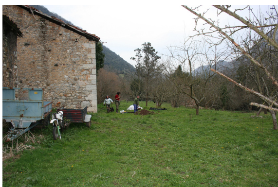
Figura 121. Zona intervenida, IT-PMR10
