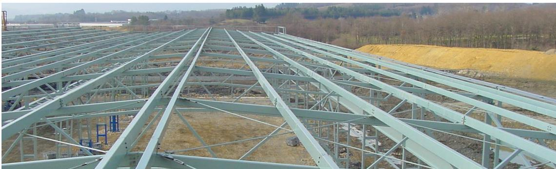
Figura 1.5 Solución para correas de cubierta mediante perfiles tubulares de acero
