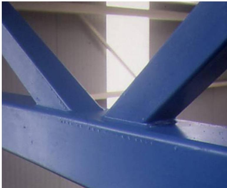
Figura 1.22 Unión en K con espaciado entre perfiles RHS
