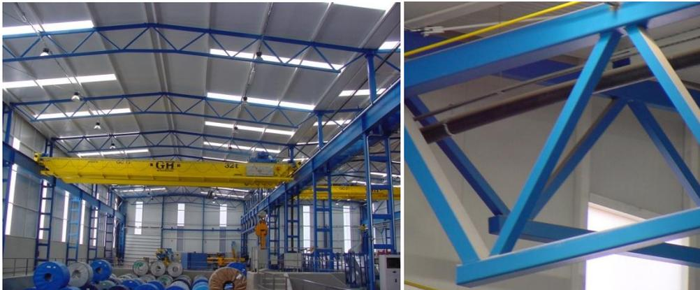
Figura 1.9 Interior y detalle de la estructura de un edificio industrial resuelta con perfiles RHS
