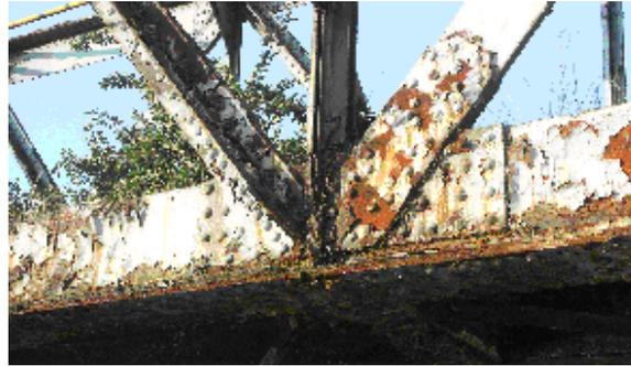
Figura 1.16 Ejemplo de estructura de acero afectada severamente por la corrosión
