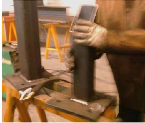
Figura 4.21 Soldeo de la placa de anclaje a la barra de relleno a tracción
