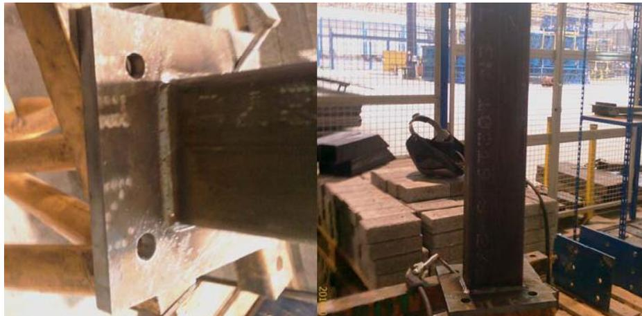
Figura 4.20 Soldeo de la placa de anclaje al extremo comprimido del cordón
