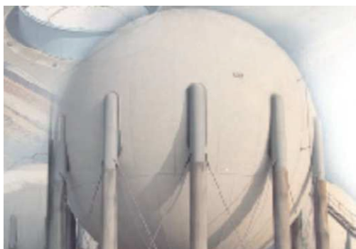
Figura 1. Por ejemplo, el gas natural licuado se almacena a presión atmosférica y a T^a de -161^{\circ}\text{C} . En su interior no hay aire, luego no se aplica el RD681/2003
