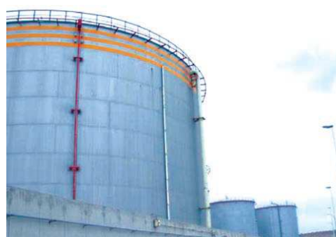
Figura 2. Muchos hidrocarburos se almacenan a T^a y presión atmosféricas. Por tanto, si la sustancia emite vapores y en el interior hay aire, hay que aplicar el RD 681/2003
