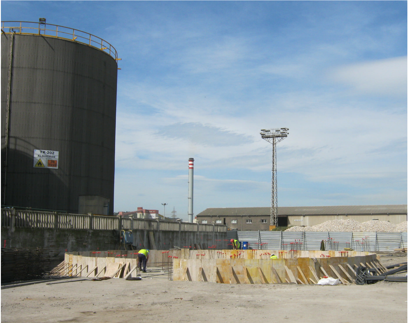
Fotografía 1.3 Vista de la ubicación de los nuevos depósitos
