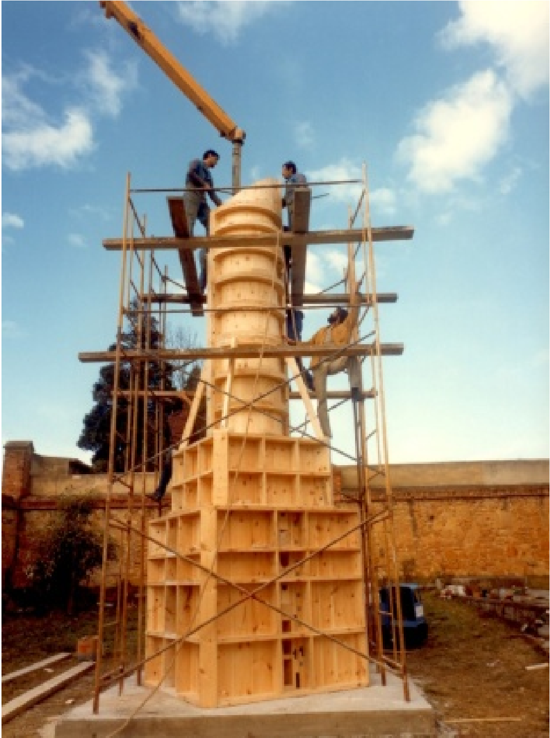
Imagen del encofrado de la obra. 1986
