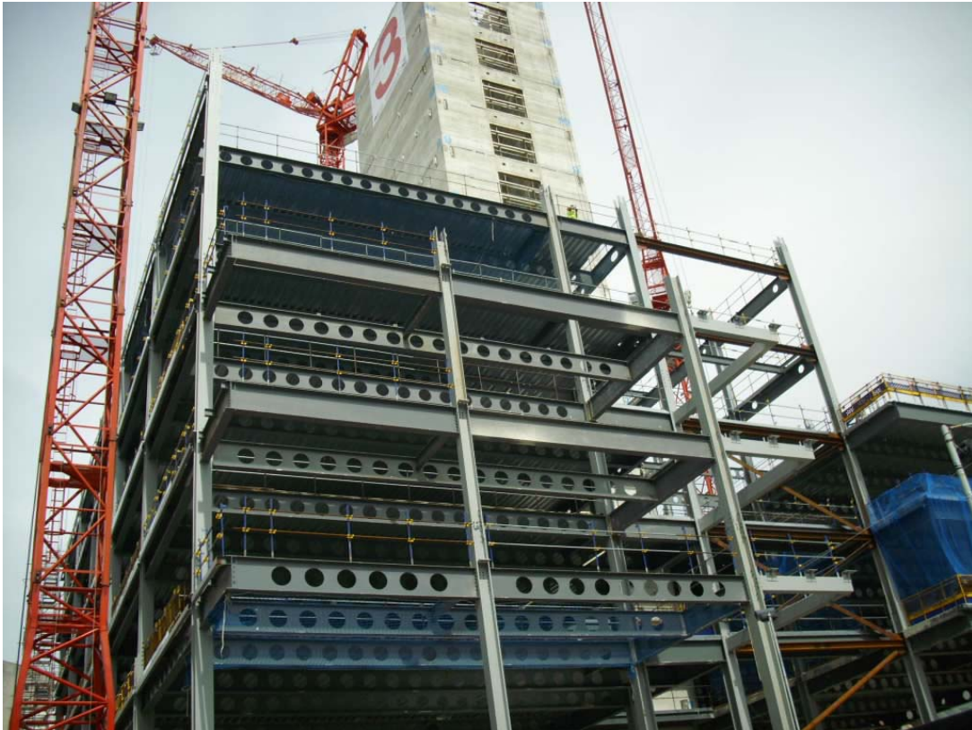
Figura 77.- Edificio de estructura metálica
