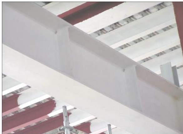
Figura 27.- Detalle de aplicación de pintura intumescente en una viga para una entreplanta
