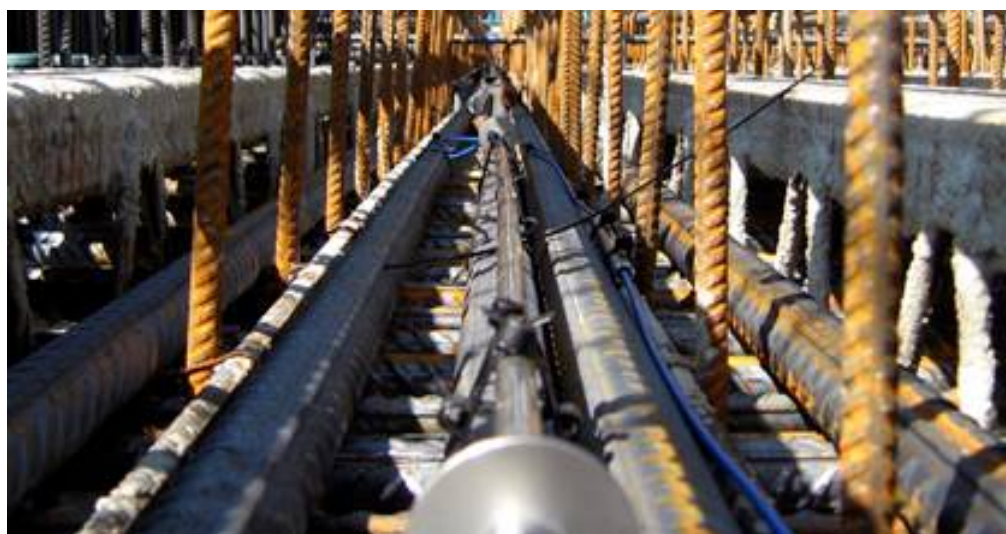
Figura 73.- Colocación de fibra óptica dentro de una estructura
