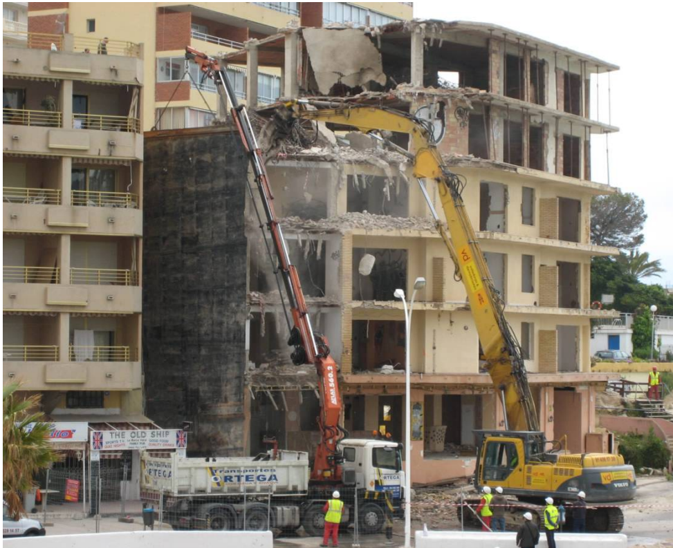
Figura 78.- Demolición de un edificio
