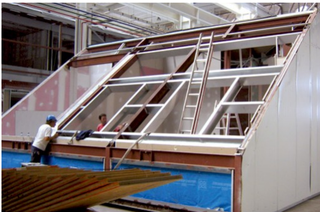
Figura 13.- Montaje de la cubierta
