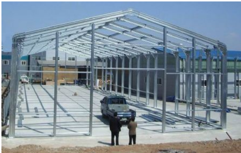
Figura 25.- Estructura metálica en USA
