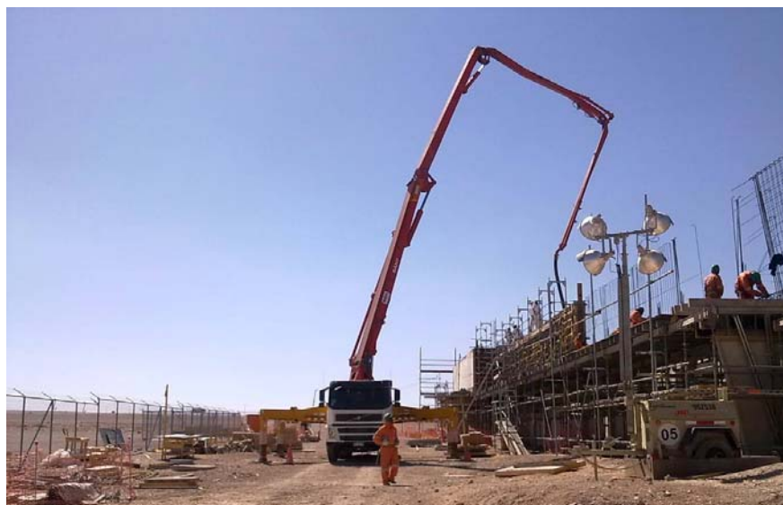
Figura 41.- Trabajos de hormigonado en obra
