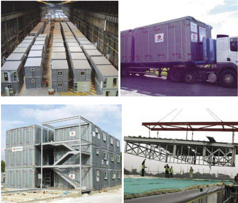
Figura 20.- Fabricación y montaje de módulos [CORUS]
