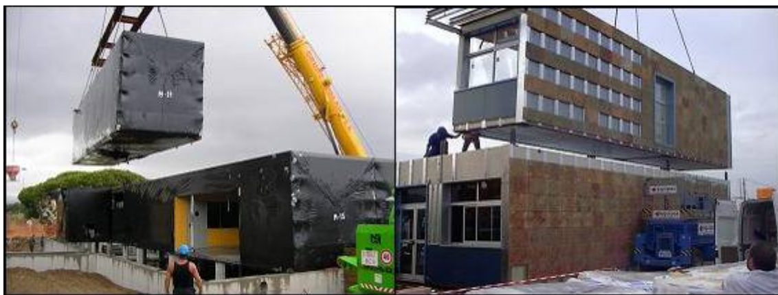
Figura 11.- Secuencia de montaje de un módulo
