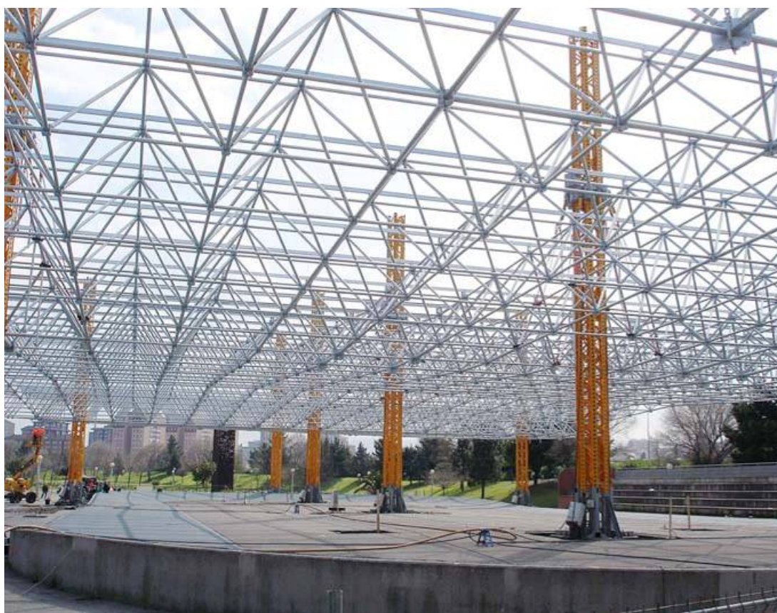
Figura 66.- Elevación de cubiertas industriales
