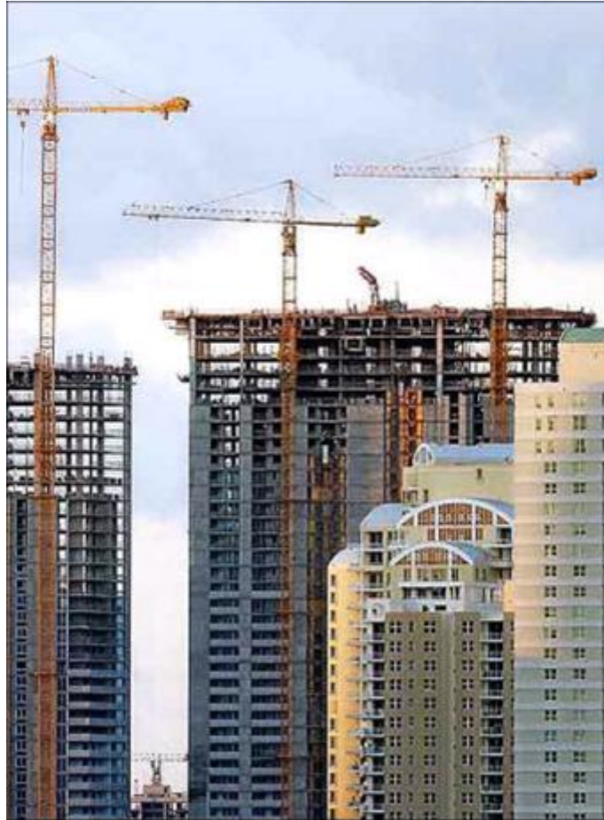
Figura 10.- Edificios en construcción mediante sistemas tradicionales
