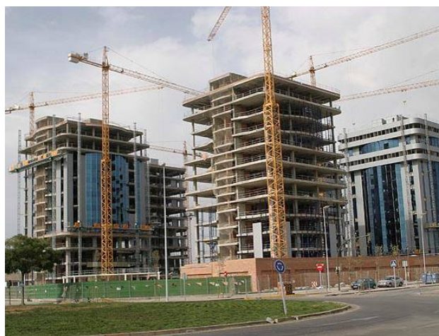
Figura 30.- Edificios en construcción
