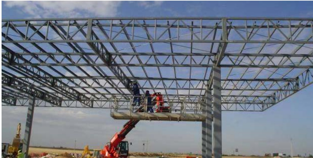
Figura 40.- Trabajos de soldadura en obra
