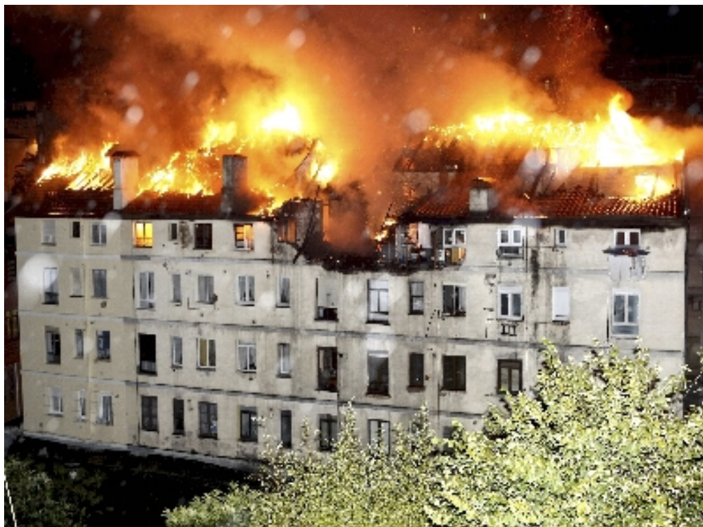
Figura 35.- Incendio de un edificio
