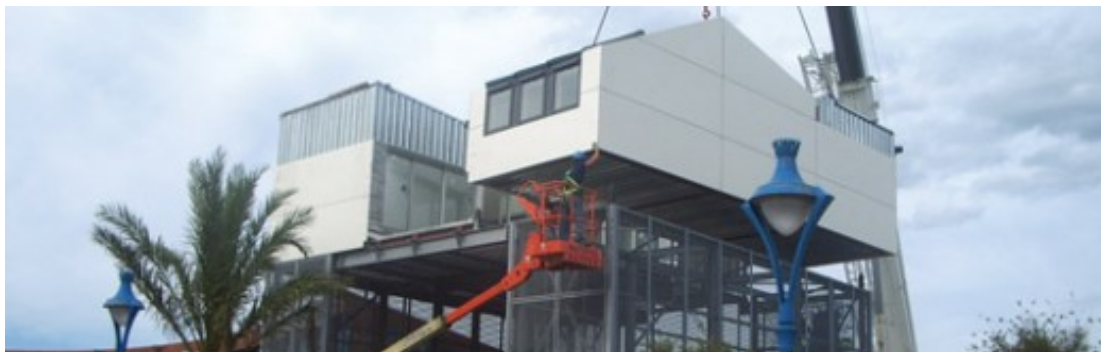
Figura 14.- Montaje en obra
