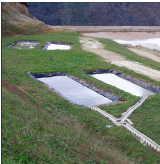
Fig. 77. Vista general del sistema. La línea de la izquierda es el tratamiento diseñado y la línea de la derecha, el blanco.
