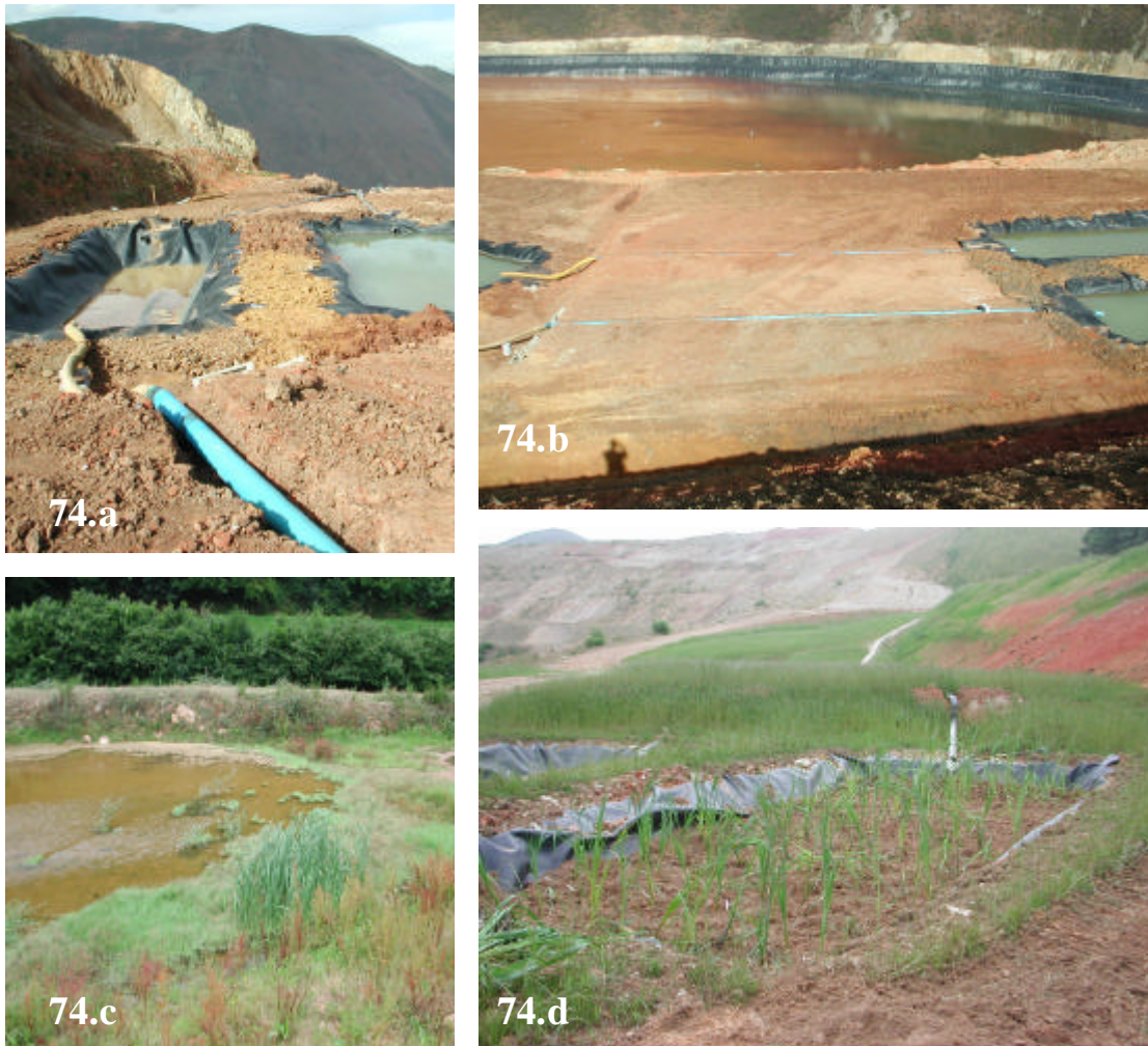
Fig 74. Vistas de la segunda celda (aerobia) del tratamiento: Fig 74.a y 74.b. Detalles de la conducción de la solución desde la primera celda a la segunda. Fig 74.c. Humedal natural donde fueron recolectados los ejemplares de Thypha latifolia plantados en la celda del sistema. Fig 74.d. Disposición final de la celda, tras el transplante.
