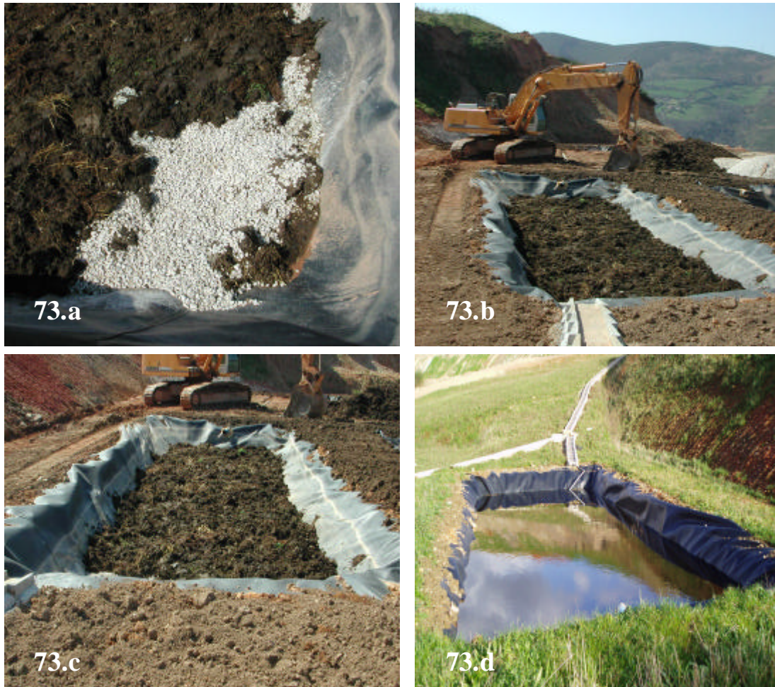
Fig 73. Vistas de la primera celda (anaerobia) del tratamiento: Fig 73.a. Detalle de las capas de relleno: estiércol (superior) y grava (inferior) Fig 73.b. Proceso de llenado de la celda Fig 73.c. Detalle de la celda, una vez rellena Fig 73.d. Celda anaerobia en funcionamiento
