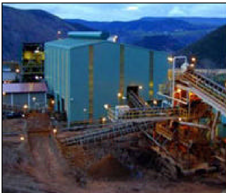
Fig. 17. Vista parcial de una planta de cianuración. Yacimiento "El Valle-Boinás" (Asturias)
