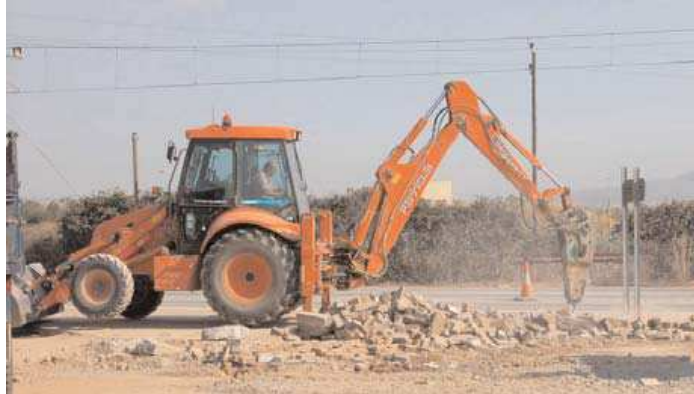
Figura 3.2. Retroexcavadora con martillo neumático (construmática, 2011)
