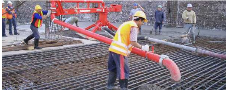
Figura 3.12. Maquinaria para el bombeo de hormigón (Carlos Aguilar, 2011)
