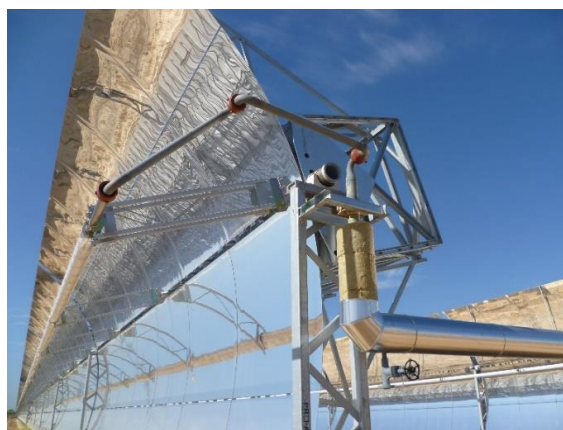
Ilustración 9: Tubo absorbedor y espejo reflector
