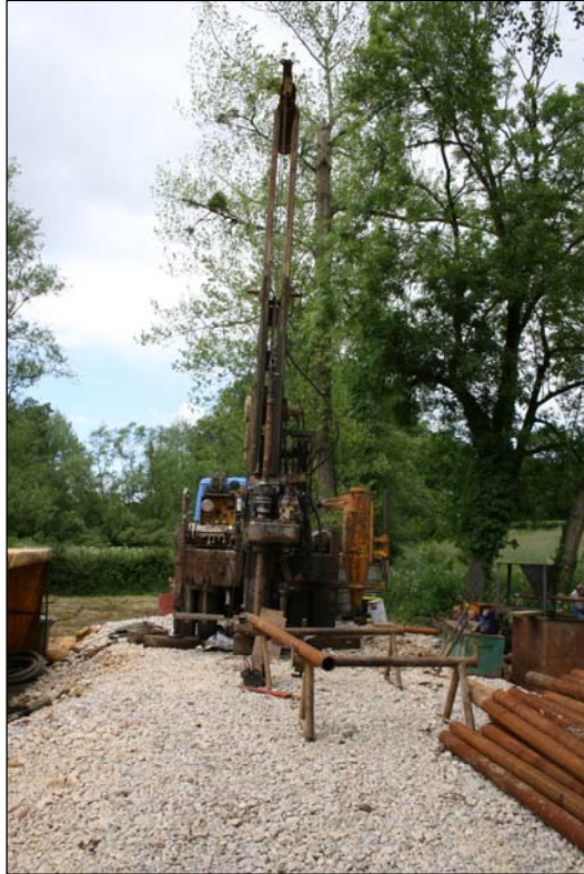
Ejecución del sondeo PZ-2 con extracción de testigo continuo.
