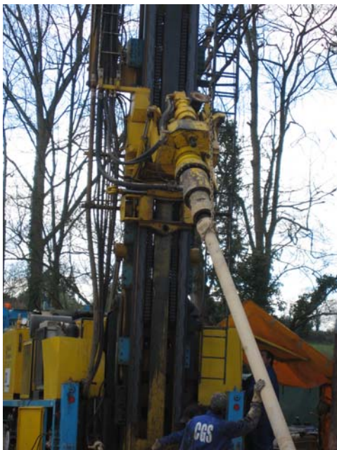
Trabajos para entubación del pozo.
