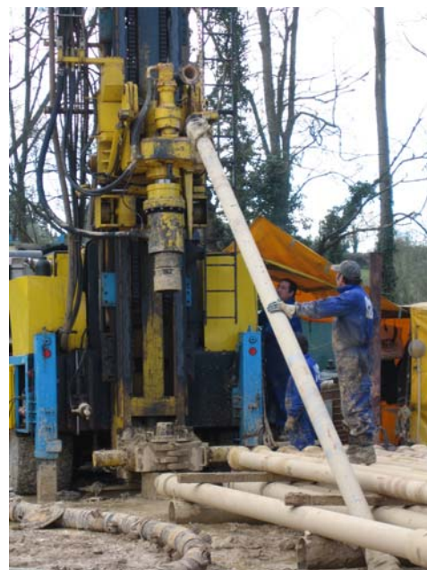
Trabajos para entubación del pozo.
