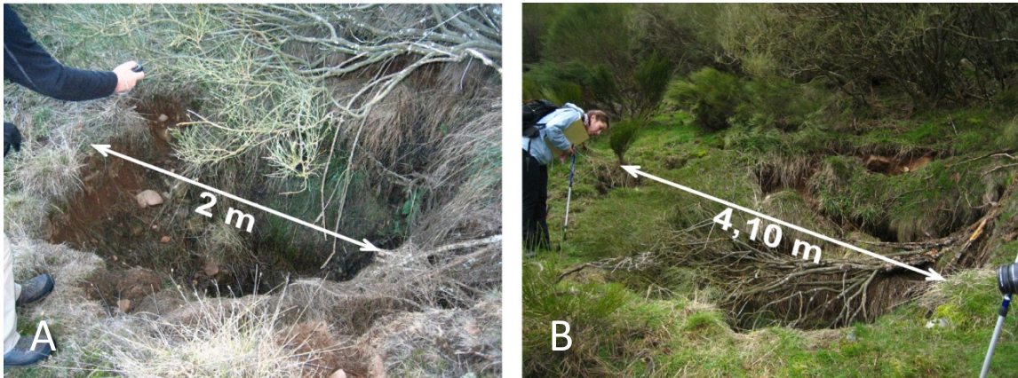
Figura 12. Crecimiento del socavón I durante el periodo de investigación. Fotos correspondientes al 07/01/2013 (A) y al 13/04/2013 (B).
