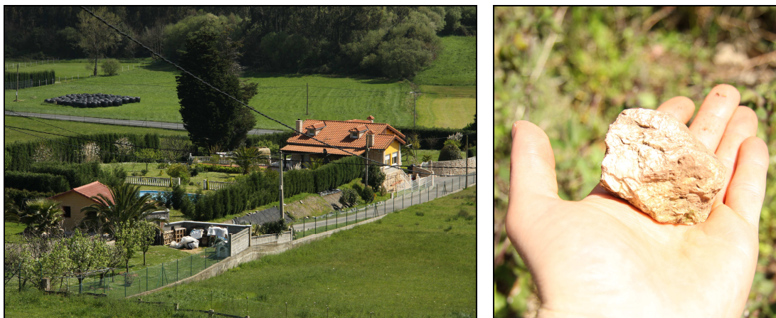
Fotografía 1.5 (Izquierda) - Construcción actual de una vivienda unifamiliar sobre las antiguas escombreras de una mina de barita en las cercanías de Luanco. Fotografía 1.6 (Derecha) - Muestra de mano de este mineral.
