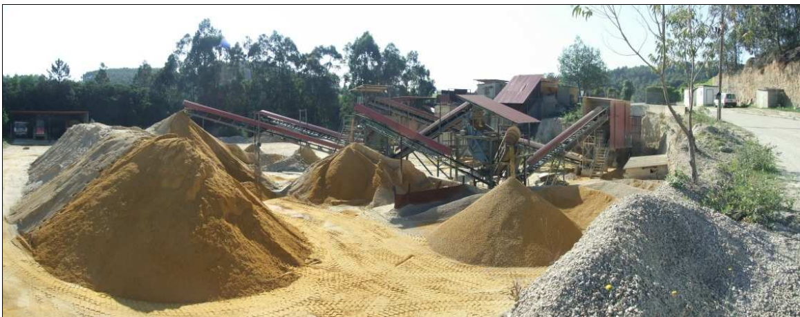
Fotografía 4.42 - Planta de tratamiento de conglomerado y arenas. Cantera La Rebollada (n° 208).
