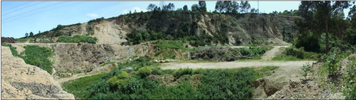
Fotografía 4.45 - Vista general de la plaza de cantera y los frentes de la explotación n° 215.
