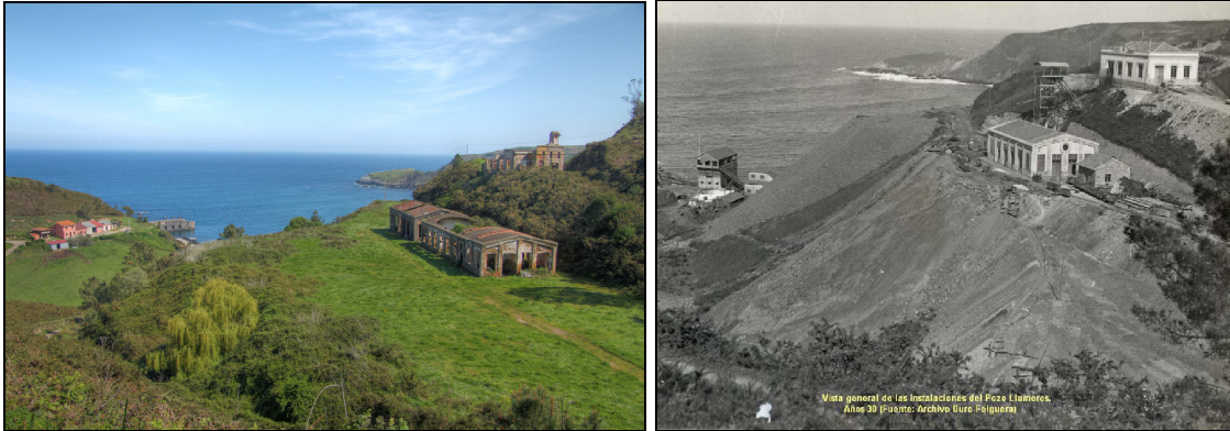
Fotografías 7.3 y 7.4 - Comparación entre las instalaciones actuales de la Mina de Llumeres (nº 56) en la actualidad (izquierda) y en la época de explotación (derecha).
