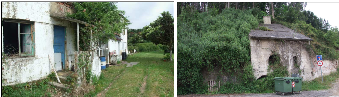
Fotografía 7.1 -: Instalaciones abandonadas de la Mina Los Gavianes. (nº 68). Fotografía 7.12 - Instalaciones abandonadas de la Mina Miluca (nº 67).
