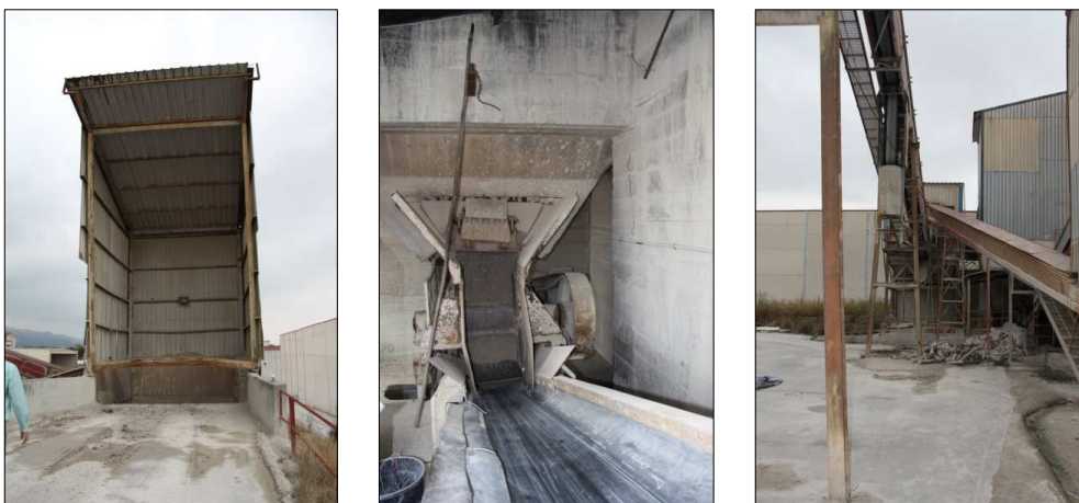
Fotografía 5.10 - Tolva de recepción de caolín para su posterior molienda y cribado.
