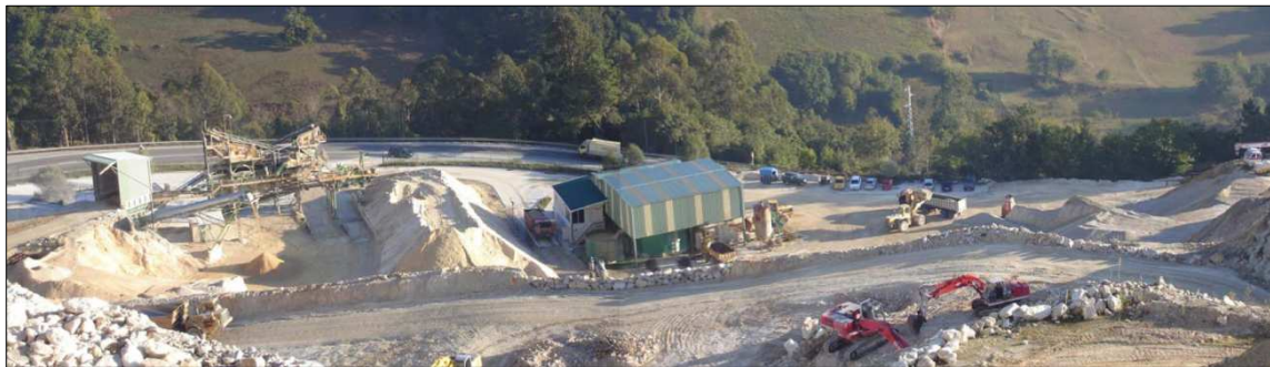
Fotografía 4.7 - Planta de tratamiento de la explotación Manuela-Julia 2ª Ampliación.
