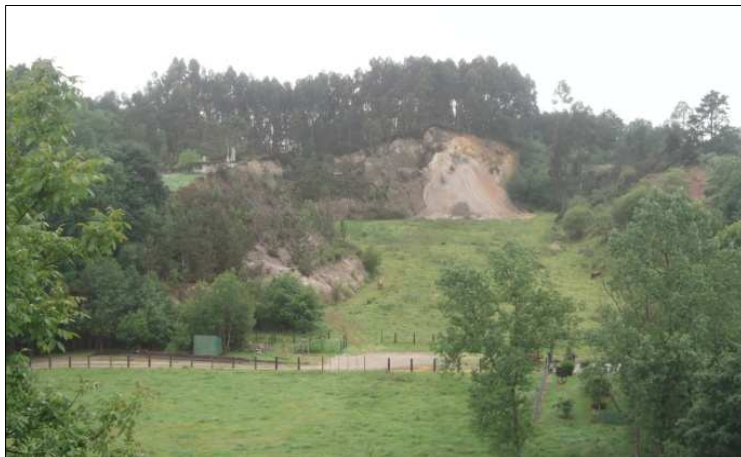
Fotografía 4.43 - Antigua zona de explotación de la cantera nº 264, totalmente restaurada pero con problemas de estabilidad de taludes.
