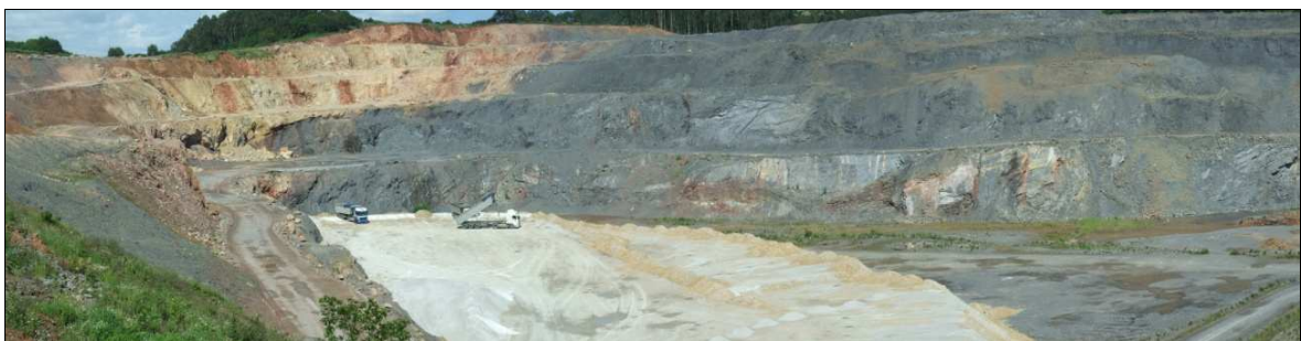
Fotografía 4.66 - Explotación El Perecil (nº 34): a la izquierda y al fondo, en tonos beige, calizas dolomíticas de la Fm. Barcaliente; en tonos oscuros, en el centro y derecha, materiales pizarrosos del Mb. Pinos de la Fm. San Emiliano.
