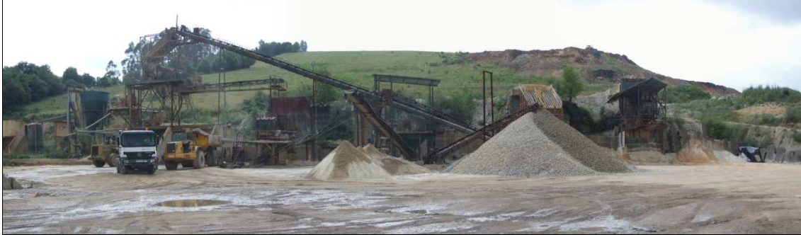
Fotografía 5.1 - Planta de tratamiento de conglomerados y arenas de la Fm. Pola de Siero de la cantera La Carba.
