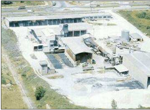
Fotografía 5.7 - Vista aérea de la planta de tratamiento de la empresa Arcichamotas en el Polígono Industrial de Silvota.
