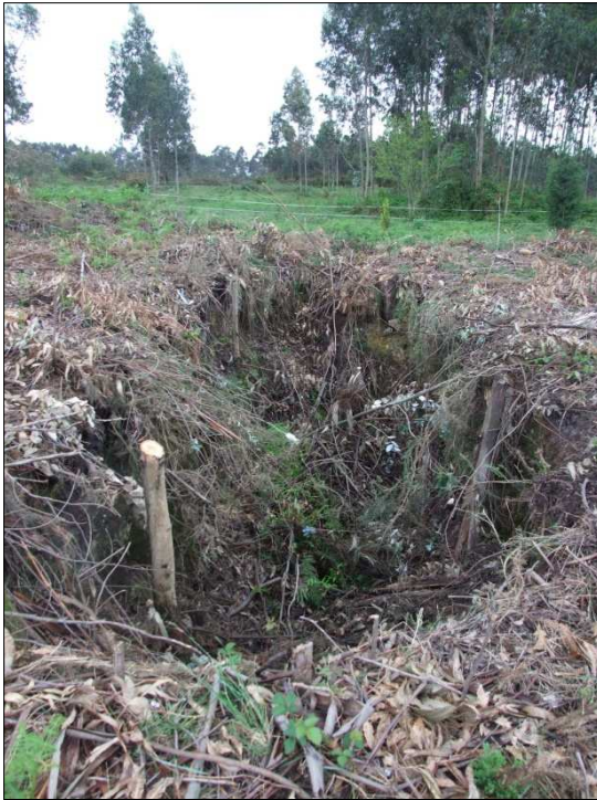
Fotografía 4.26 - Hundimientos de las galerías de explotación de caolín de la Mina Kao-ling (nº 521) en Carreño. La tala de árboles en la finca ha permitido reconocer la dirección que seguían las galerías.
