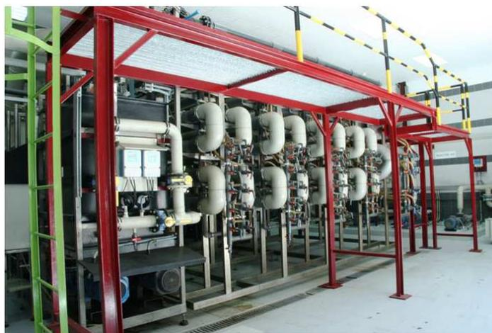
**Figura 7. Sistema de ultrafiltración de fangos. (Fuente: Cogersa).**
