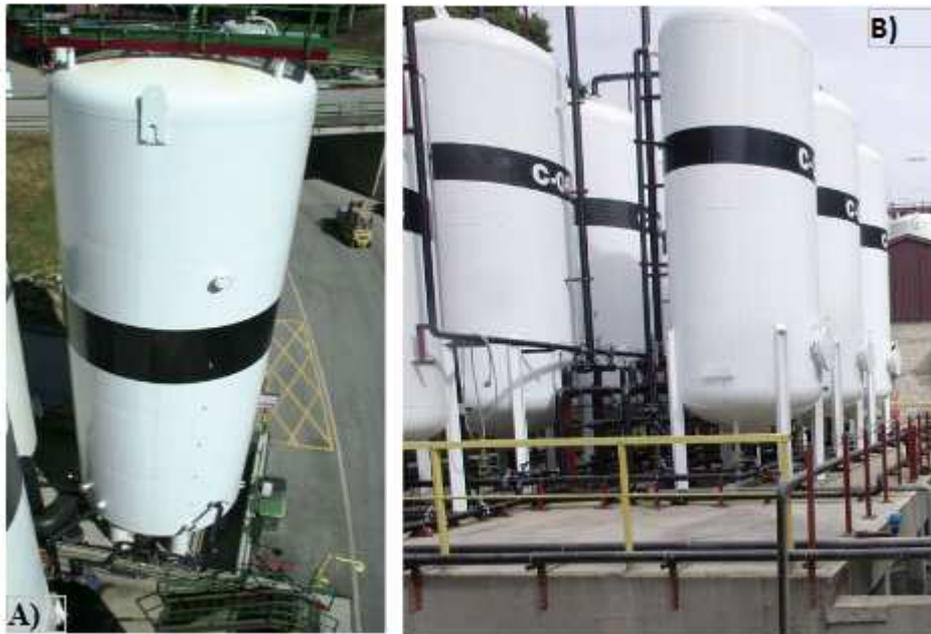
**Figura 4. Reactores; A) Reactor del proceso de tratamiento biológico; B) Reactores del tratamiento terciario con carbono activo. (Fuente: Cogersa).**
