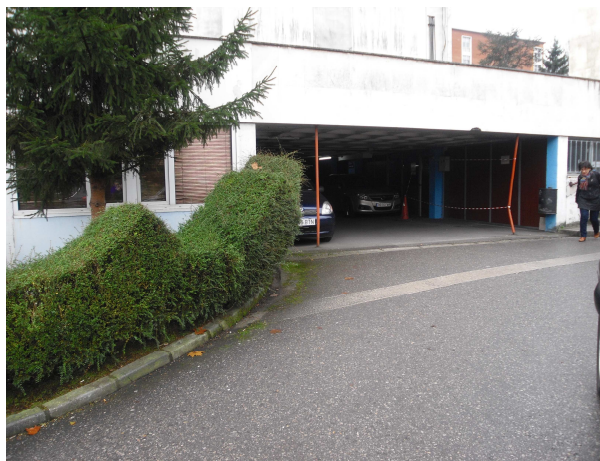
Figura 6. Imagen de la salida de coches del garaje contiguo a la zona de descanso de los técnicos de ambulancia – Oviedo.
