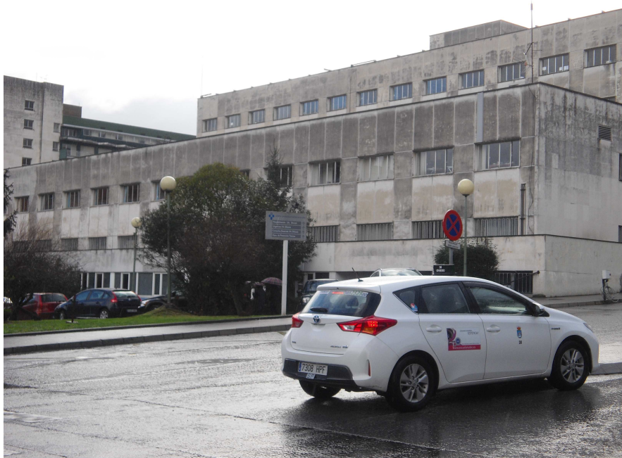
Figura 4. Parte de atrás del edificio de consultas externas del HUCA donde se encuentra la base del SAMU de la UME-IV - Oviedo.
