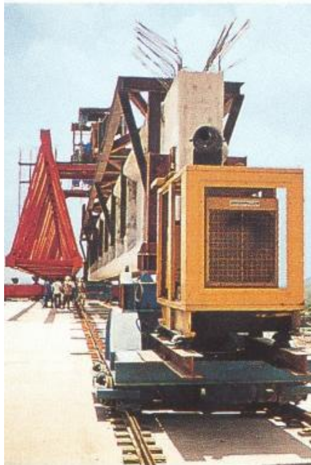
Figura 2. Transporte del puente sobre raíles utilizando locomotora.
