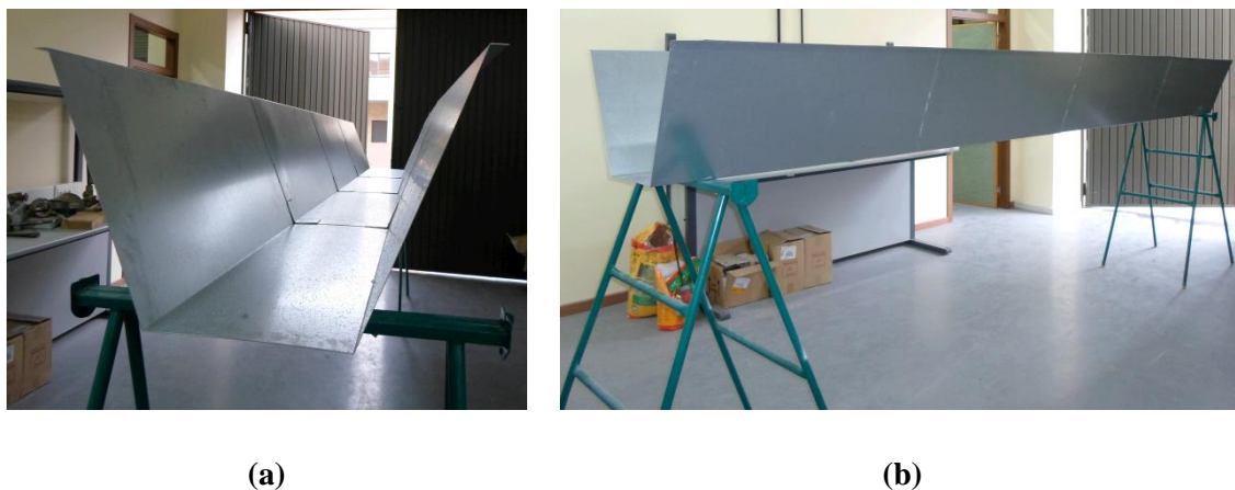
Figura 87. Montaje de 4 m. del prototipo del puente: (a) canto; (b) vista longitudinal.
