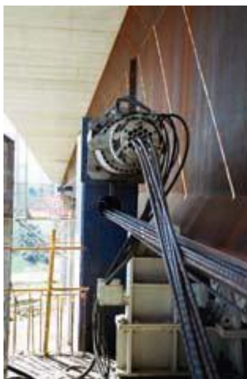
Figura 8. Sistema actual mediante tiro con cable.
