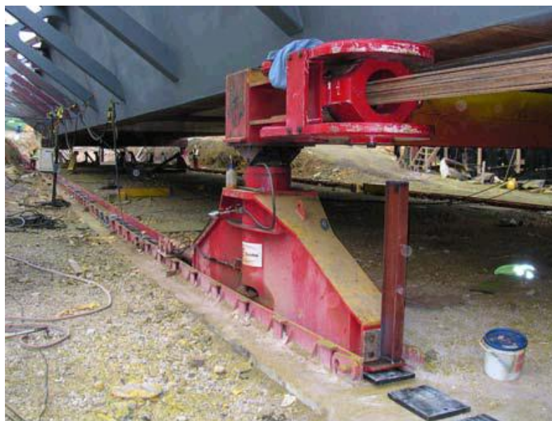
Figura 6. Sistema de tiro con cable.
