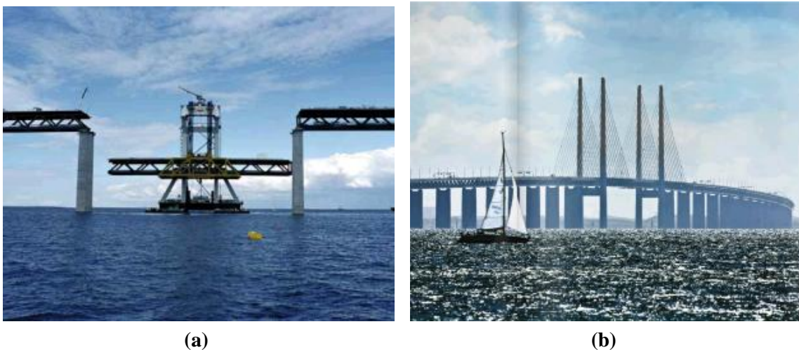
Figura 4. Puente Öresund (Suecia – Dinamarca): (a) fotografía del transporte de la estructura durante su construcción; (b) fotografía del puente en servicio.
