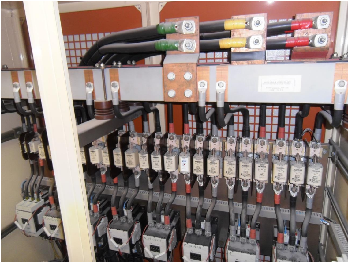
Entrada de energía, embarrado, fusibles, contactores y condensadores del equipo de control de la energía reactiva.
