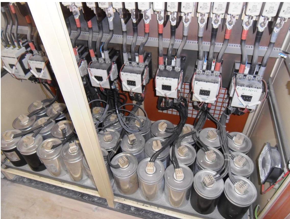
Entrada de energía, embarrado, fusibles, contactores y condensadores del equipo de control de la energía reactiva.
