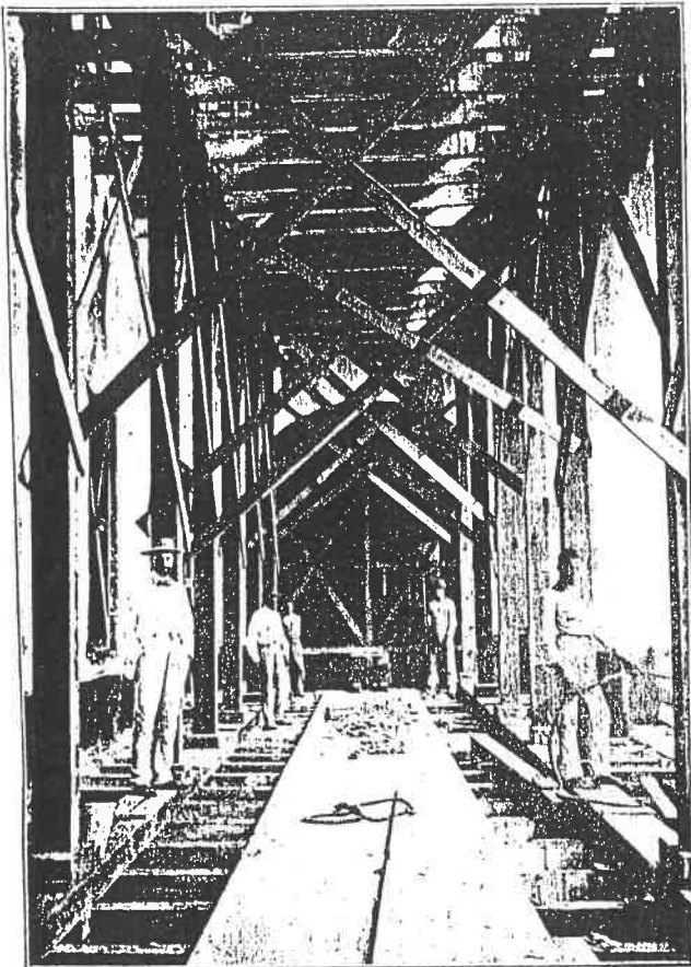
APES DEL PISO DE LA GALERÍA PRINCIPAL.
