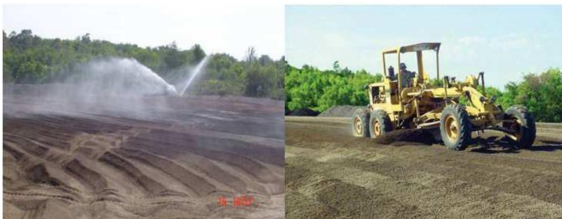
**Figura 4.3.** Regadío con agua y aireación de la escoria LD
