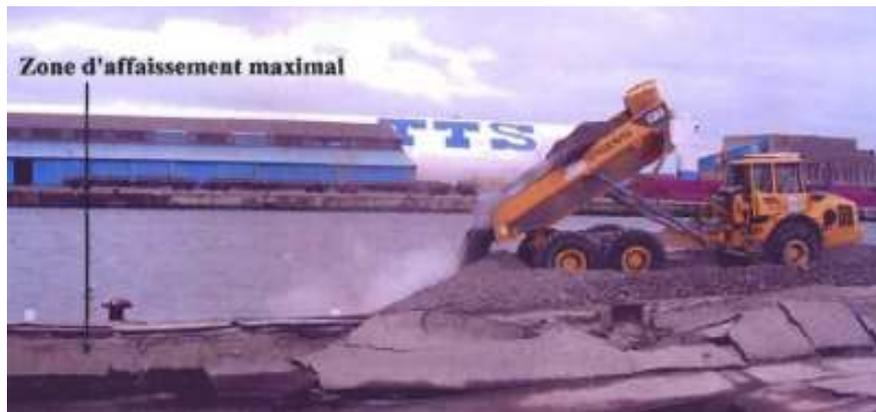
**Figura 3.9.** Refuerzo muelle Freycinet 11 en Dunkerque con escoria LD
