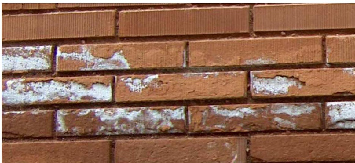
**Figura 7.18.** Detalle eflorescencia en ladrillo cara vista
