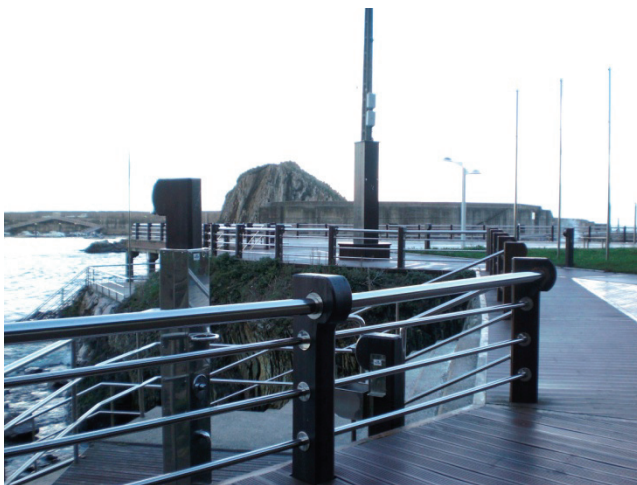
Fig. 6. Zona de estancia en el entorno del puerto de Cudillero. Fotografía de la autora, tomada el 01-12-2012.
