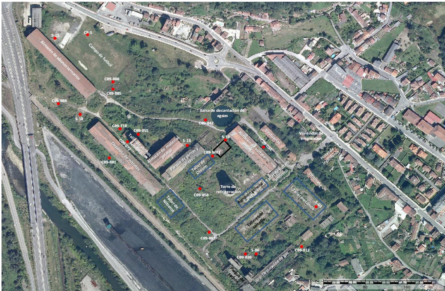
Fig.2.7. Ortofotografía PNOA © del Instituto Geográfico Nacional de España - (Principado de Asturias) de Nitrastur, mostrando las instalaciones. Los puntos indican la ubicación de los sondeos y las calicatas.
