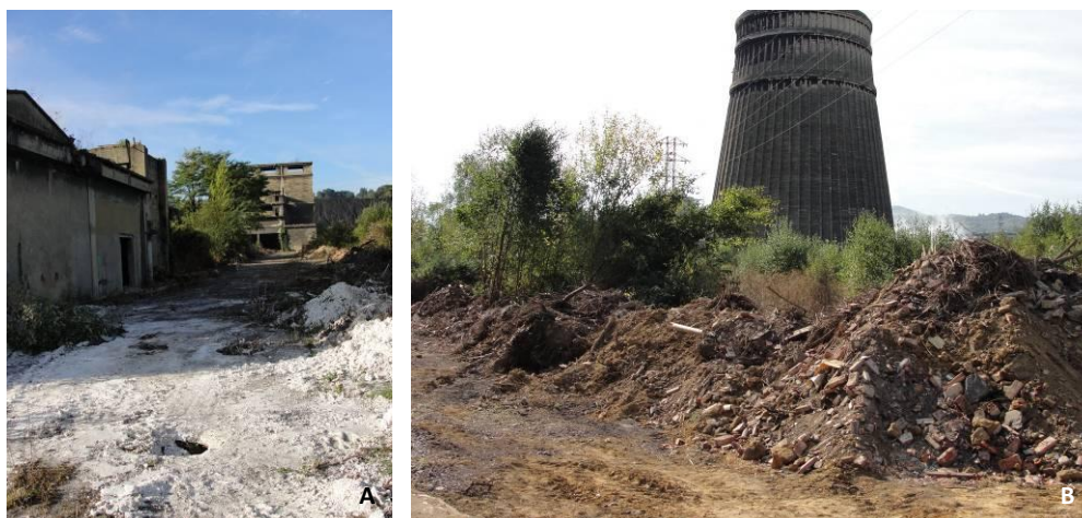
Fig.2.5.: A) Vertido de un polvo blanco no identificado, B) Tierra removida en la que se observan escombros.
