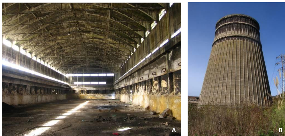
Fig.2.6.: A) Interior del almacén de sulfatos, B) Chimenea de refrigeración.
