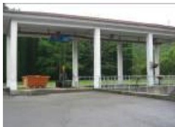
Pozo de gruesos
