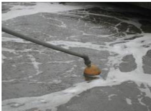
Reactor biológico Producción de fangos biológicos
