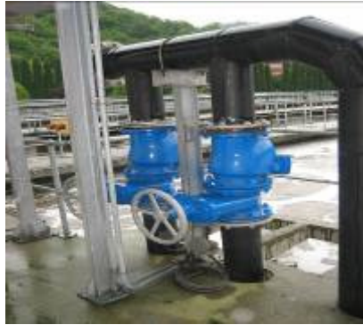
Reactor biológico Recirculación interna
