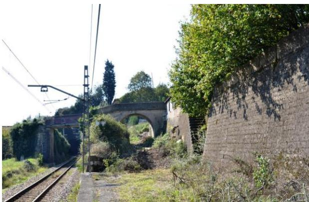
Figura 29. Estado actual del punto donde se establecería la conexión entre el Vasco-Asturiano y la línea Pravia-Cangas de Tineo. Como se puede apreciar, la caja de la vía llegó a realizarse, si bien nunca llegaron a instalarse los raíles y, por ende, a circular ningún tren.
