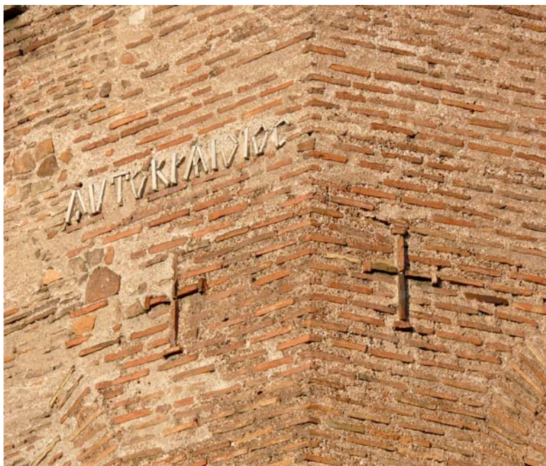
Fig. 29. Detalle de la torre amoriana del extremo sur, donde se puede advertir la calidad y solidez de la construcción. Aún restan algunos vestigios de la ornamentación original, la palabra “autocrátor” en fragmentos de mármol blanco y cruces “iconoclastas” en ladrillo bordeando la esquina.
