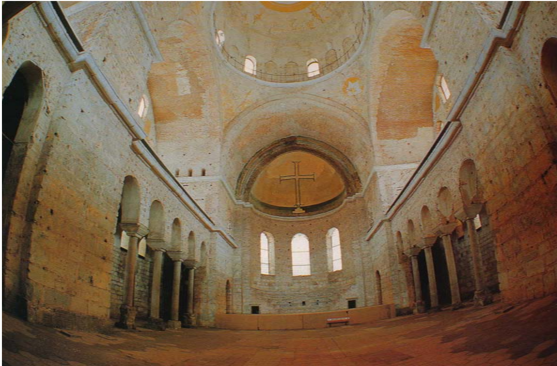
Fig. 22. Interior de la basílica de Santa Irene, de planta basilical romana, cúpula principal y naves laterales con galerías sostenidas por columnas de capiteles de 15 m de diámetro elevada a 35 m de altura con 20 ventanas.
