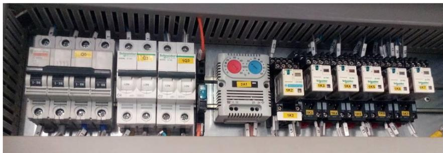
**Ilustración 33. Dispositivos de seguridad del cuadro eléctrico**
