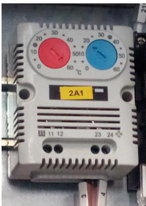
**Ilustración 36. Termostato para activación del ventilador extractor**
