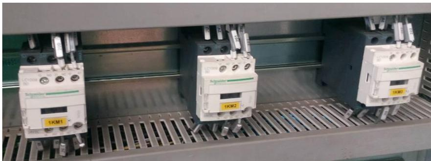
**Ilustración 35. Contactores de seguridad para los motores**
