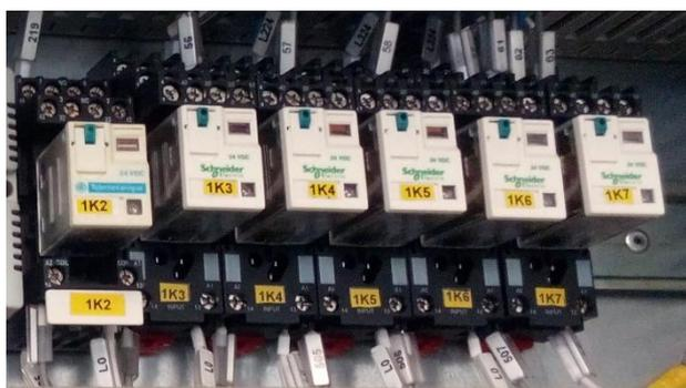
**Ilustración 34. Relés bipolares**
