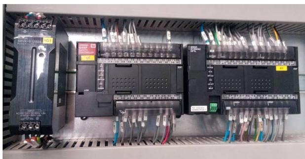
Ilustración 30. Fuente de alimentación, autómatas de seguridad y PLC de control
