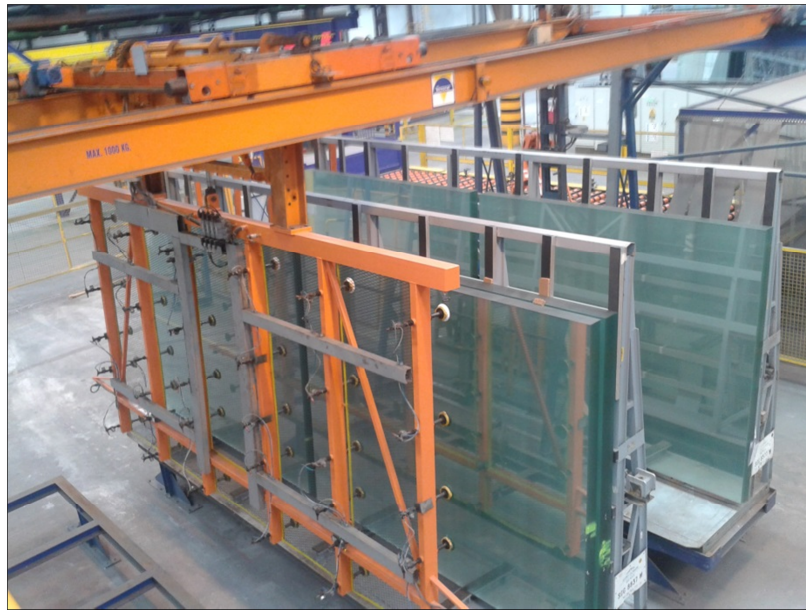
Fig. 25: Movimiento hacia atrás del puente para enfrentar el cuadro de ventosas con el vidrio.
