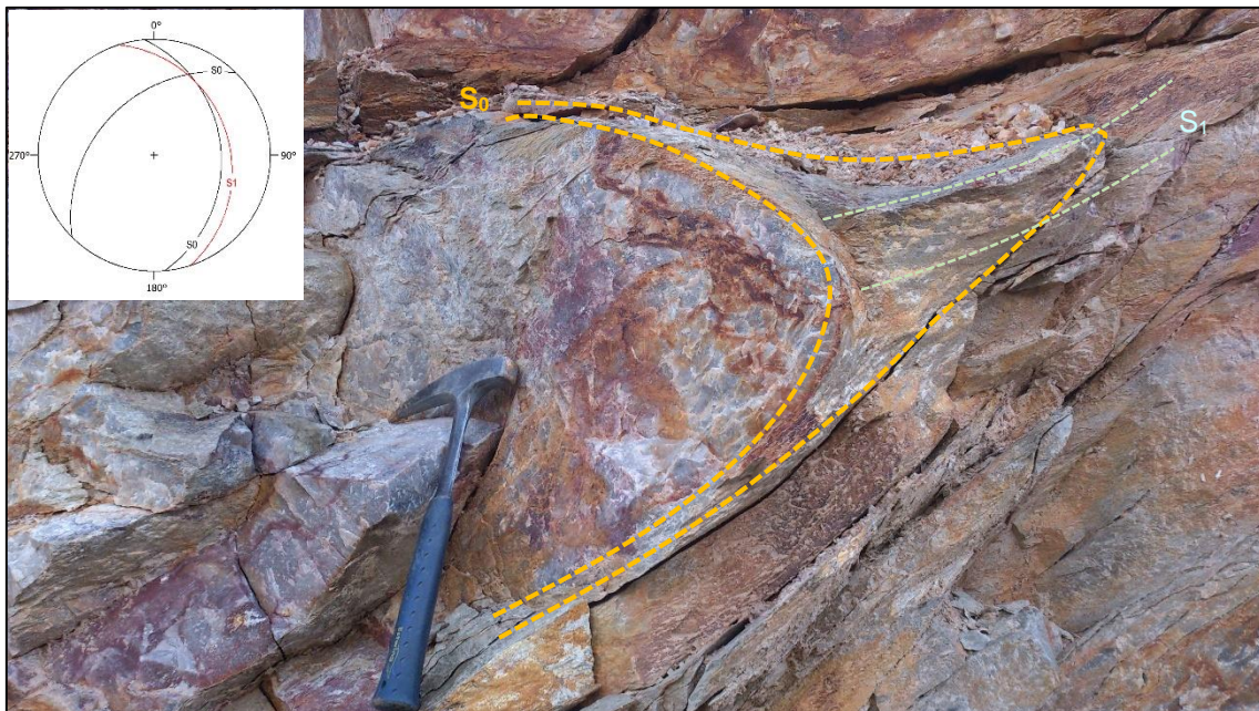
Figura 26.- Detalle de una charnela de la fotografía anterior, donde se observa la deformación que hay en los flancos de los pliegues y el engrosamiento de las charnelas por fluencia de las pizarras de los flancos hacia esas zonas. También puede verse el ángulo entre flancos (inferior a 25^\circ ) y el desarrollo claro de la esquistosidad de plano axial con estos pliegues.
