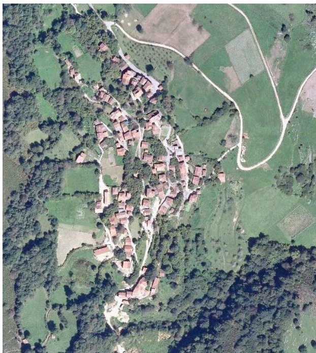
Figura 17. En la vista aérea se puede observar el pueblo de Següenco perteneciente a la parroquia de Cangas de Onís. Situado a una altitud de 600 metros es la entidad de población situada a mayor altitud dentro del Concejo. Las edificaciones que forman el núcleo tienden a apiñarse, característica típica de los pueblos de montaña. Como la gran mayoría de las entidades del concejo, a excepción de Cangas de Onís, en los últimos años ha perdido población ya que en el año 2006 contaba con 39 habitantes y en la actualidad está habitado por 35. Vista aérea obtenida del SIGPAC.
