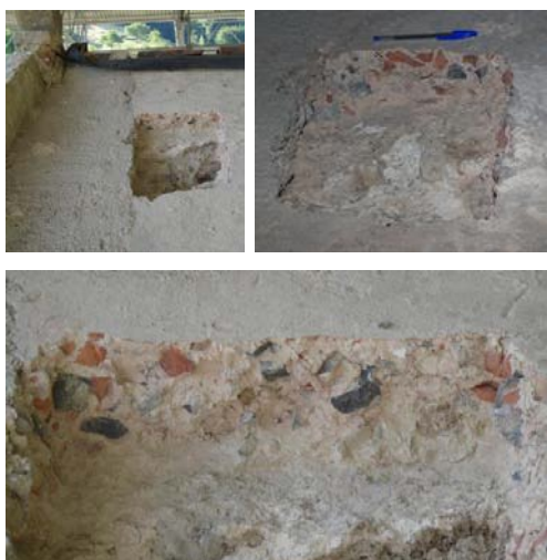
Figura 6.25.- General y detalles de la cata arqueológica practicada en la nave central donde puede observarse el hormigón del encapotado (muestra M13/CV44), con abundantes fragmentos cerámicos.
