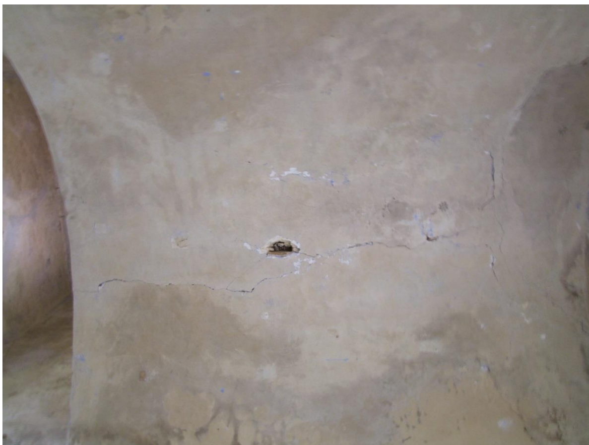
Figura 5.309.- San Miguel de Lillo. Bóveda ábside
