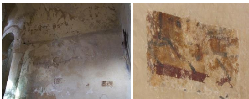
Figura 6.54.- General y detalle de las catas practicadas en el lateral norte del ábside.
