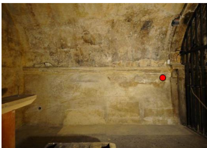
Figura 5.11.- Localización del punto de extracción de la muestra mcCS1 en el interior del camarín.
