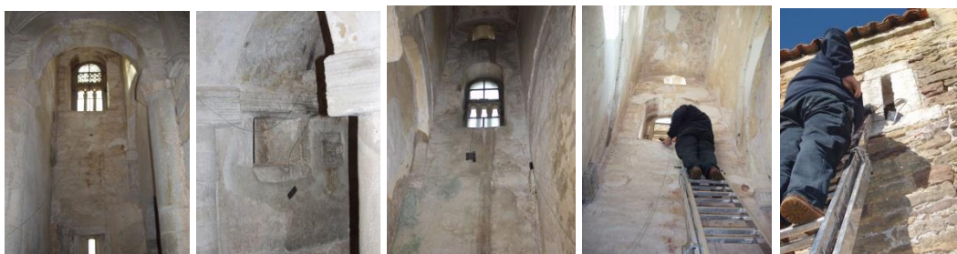
Figura 4.42.- Colocación de sondas en San Miguel de Lillo para la realización del estudio higró-termométrico, (GEA asesoría geológica, 2006).
