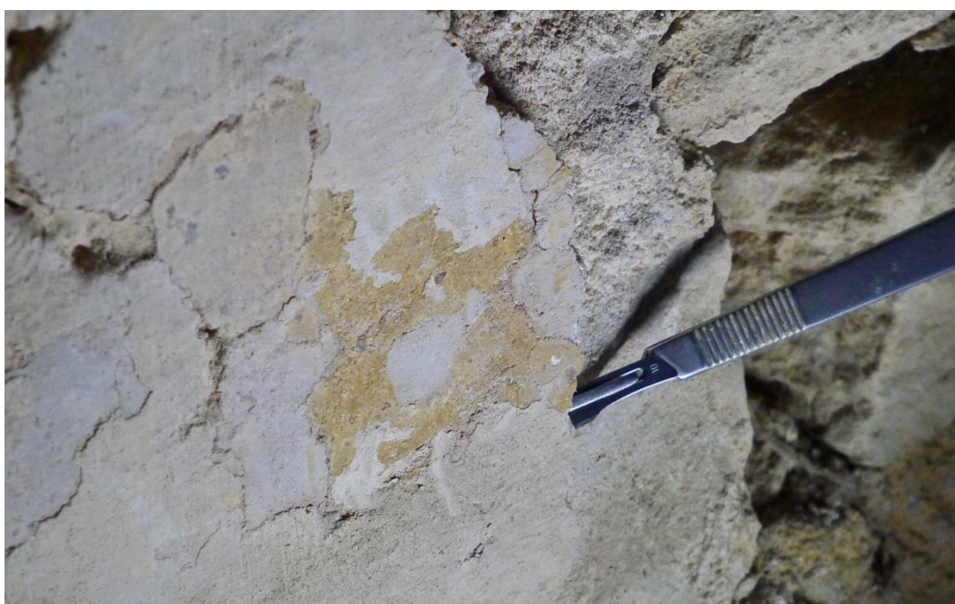
Figura 5.300.- Aspecto macroscópico «in situ» del mortero recogido en la habitación lateral sur.
