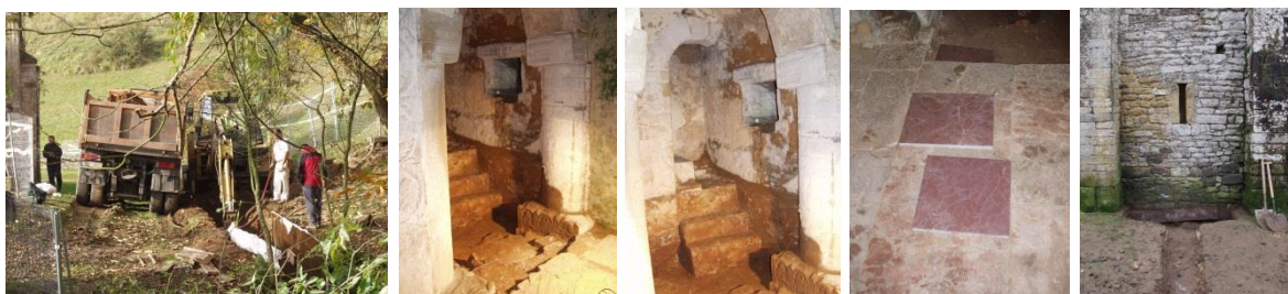
Figura 4.41.- Imágenes de algunas de las intervenciones realizadas entre los años 2005 y 2006 (labores de drenaje en el lateral norte y reposición del solado interior en la nave norte).
