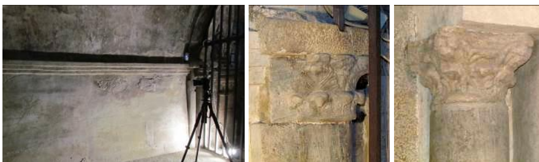
Figura 4.5.- Aspecto general de alguno de los revocos, capiteles marmóreos y columnas, localizados en el interior del camarín, una vez retirados los armarios y vitrinas que contenían las reliquias.
