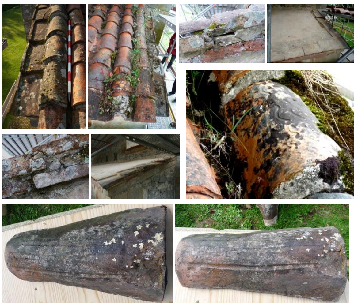
Figura 6.26.- Aspecto general y detalle de las téglulas y tejas con marcas onduladas, localizadas en San Salvador de Valdediós.
