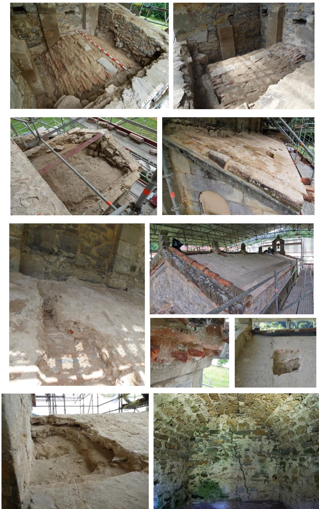
Figura 6.24.- De arriba a abajo, y de izquierda a derecha: bóvedas de la capilla de los Obispos, capilla sur, pórtico sur, nave sur, nave central, capilla mayor y cámara supraabsidal (Imágenes: Sergio Ríos y Araceli Rojo).
