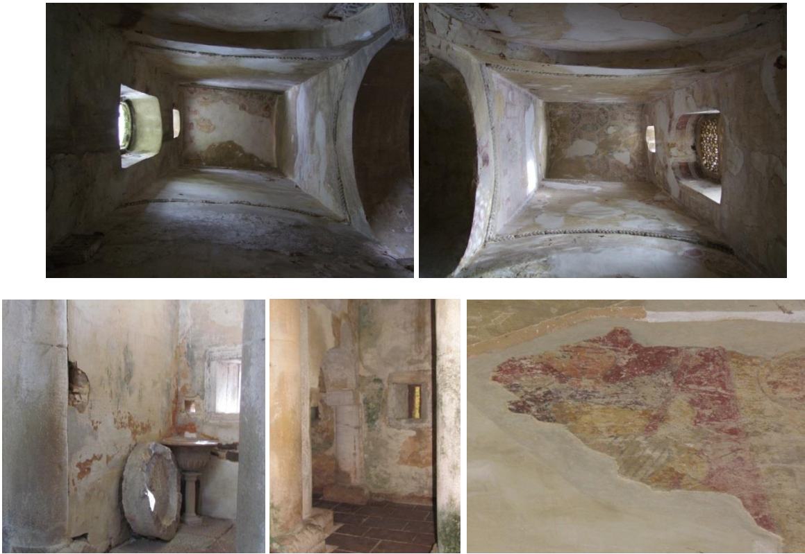
Figura 5.303.- San Miguel de Lillo. Naves norte y sur.
