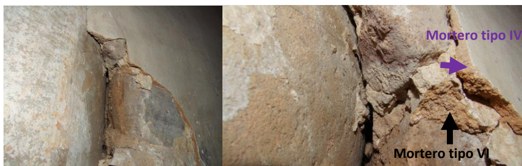
Figura 6.37.- General y detalle del mortero tipo VI, bajo el mortero tipo IV, en el arco diafragma de la nave sur.
