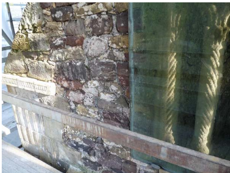
Figura 5.317.- La superficie interna del vidrio de la fachada norte presenta una intensa pátina de verdín.
