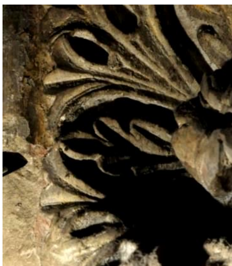
Figura 5.57.- Detalles de algunos de los restos pictóricos de albayalde rojo sobre superficies saltadas con anterioridad.
