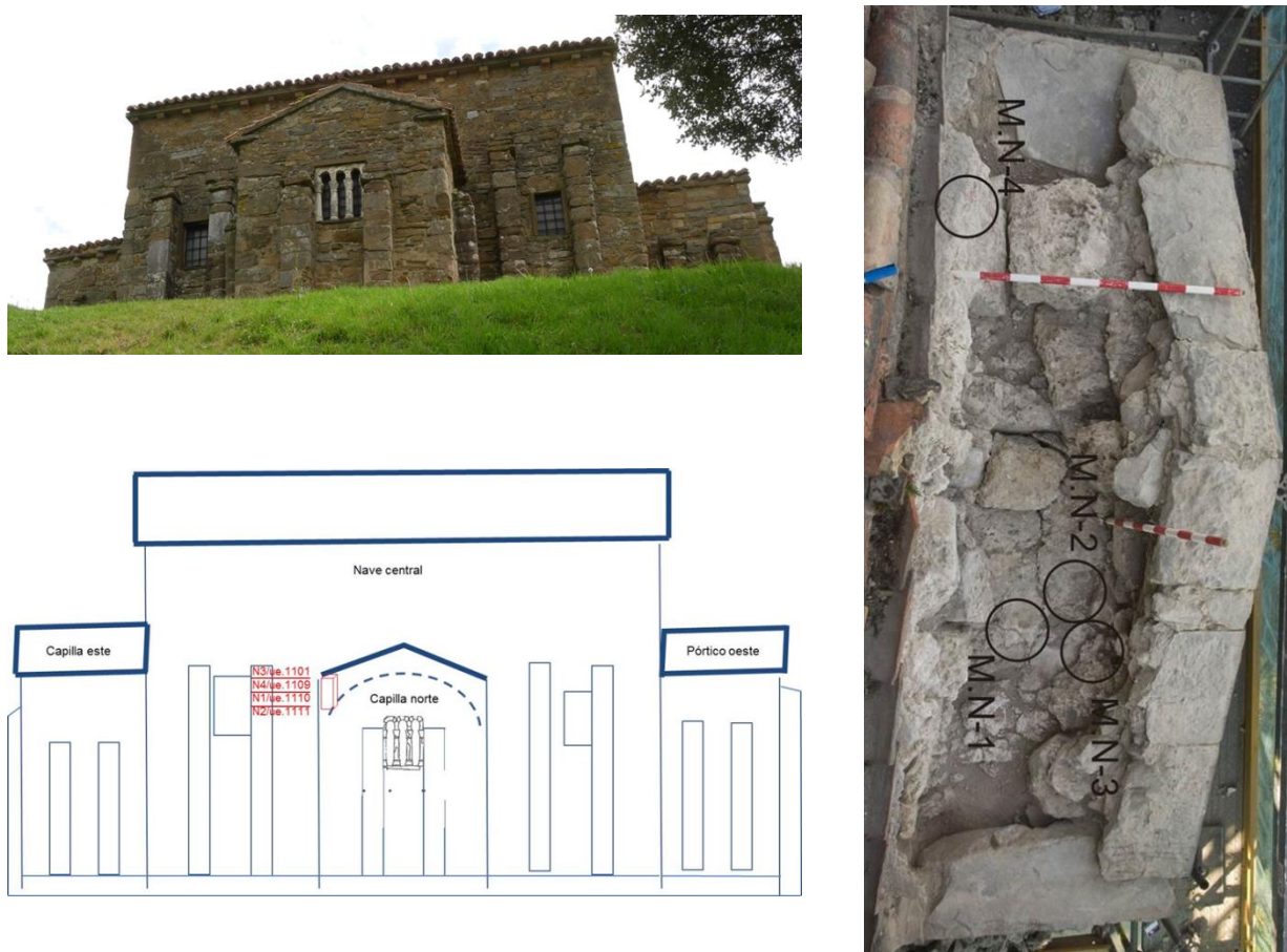
Figura 4.35.- Aspecto de la fachada norte, alzado con la localización de las muestras de mortero recogidas durante la campaña arqueológica y aspecto de la cubierta de la capilla este, durante la realización de la misma.
