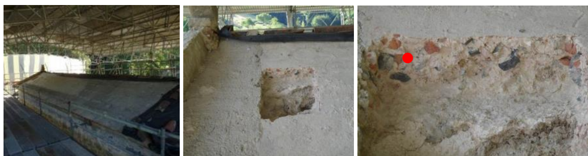
Figura 5.127.- Localización y aspecto «in situ» de la muestra de mortero M3/CV34.
