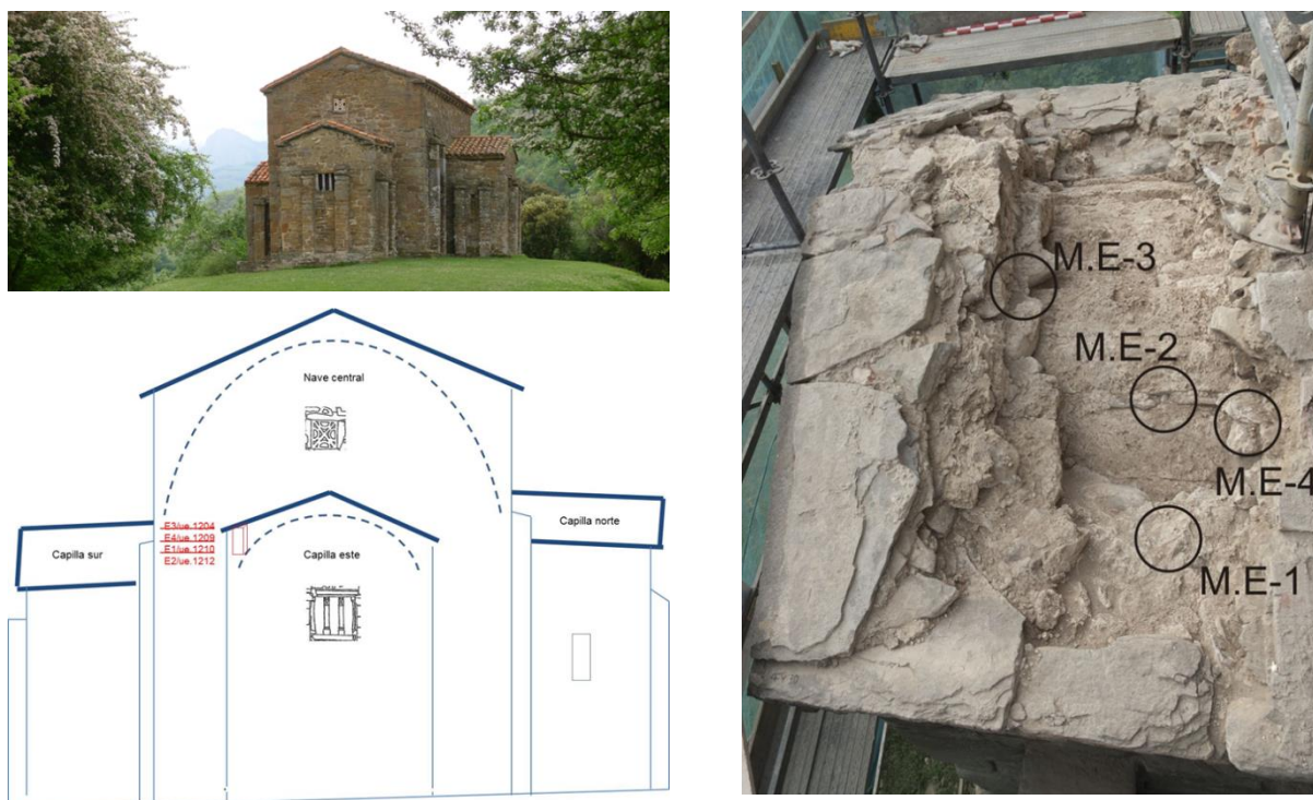
Figura 4.34.- Aspecto de la fachada este, alzado con la localización de las muestras de mortero recogidas durante la campaña arqueológica y aspecto de la cubierta de la capilla este, durante la realización de la misma.
