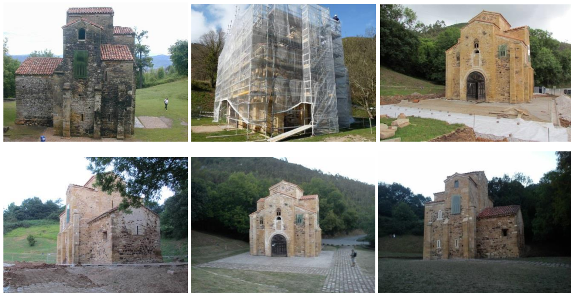
Figura 4.44.- Arriba, de izquierda a derecha; fachada norte, después de la eliminación de las colonizaciones biológicas en 2009 y fachadas este durante las obras de restauración de 2011. Abajo: fachada sur en 2011 y estado actual de la iglesia de San Miguel de Lillo (2014).
