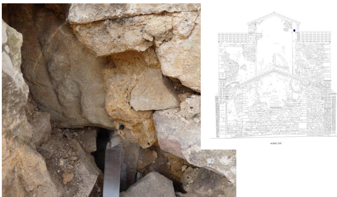
Figura 5.288.- Punto de extracción y aspecto «in situ» del mortero SML36. El mortero de fábrica de color pardo presenta abundantes fragmentos de carbón.
