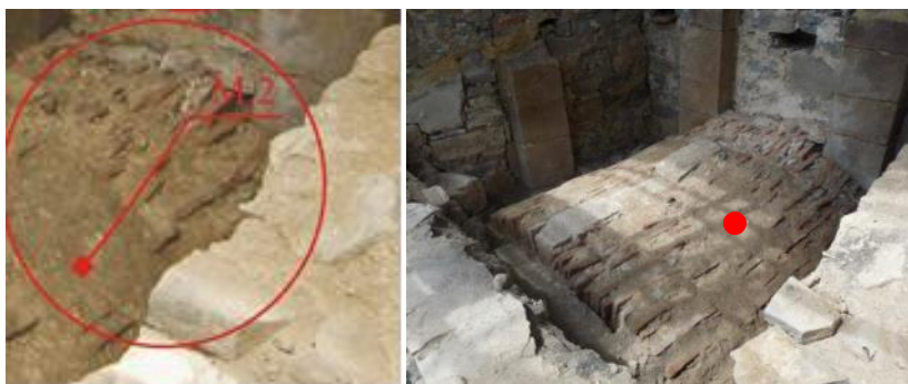
Figura 5.122.- Localización y aspecto «in situ» de la muestra de mortero M2/CV33.
