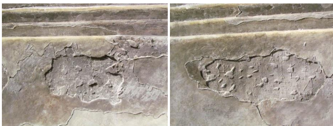
Figura 4.7.- Detalles de los antiguos revocos que se conservan en el interior del camarín. En superficie presentan signos grabados a la altura normal de una persona.
