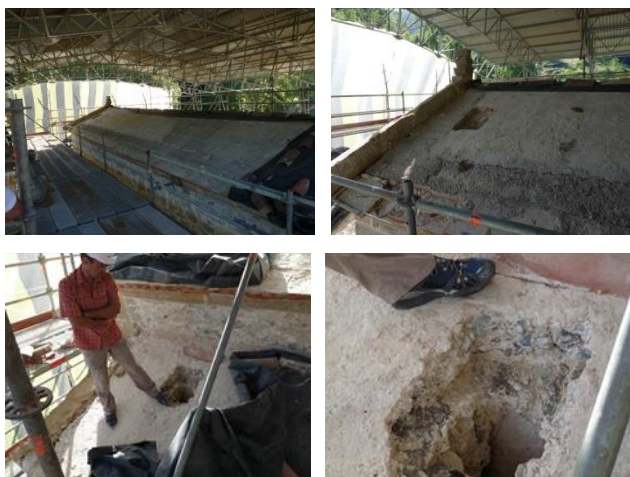
Figura 4.24.- Catas arqueológicas en la cubierta de la nave central (arriba) y en la nave norte (abajo) de San Salvador de Valdediós (2010).
