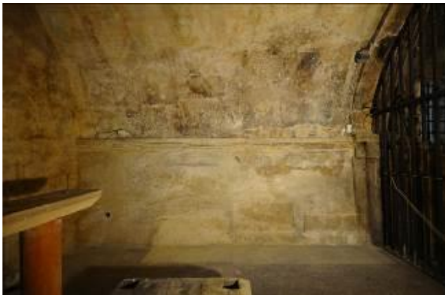
Figura 4.6.- Detalle de la bóveda sur del camarín, antes de su restauración.
