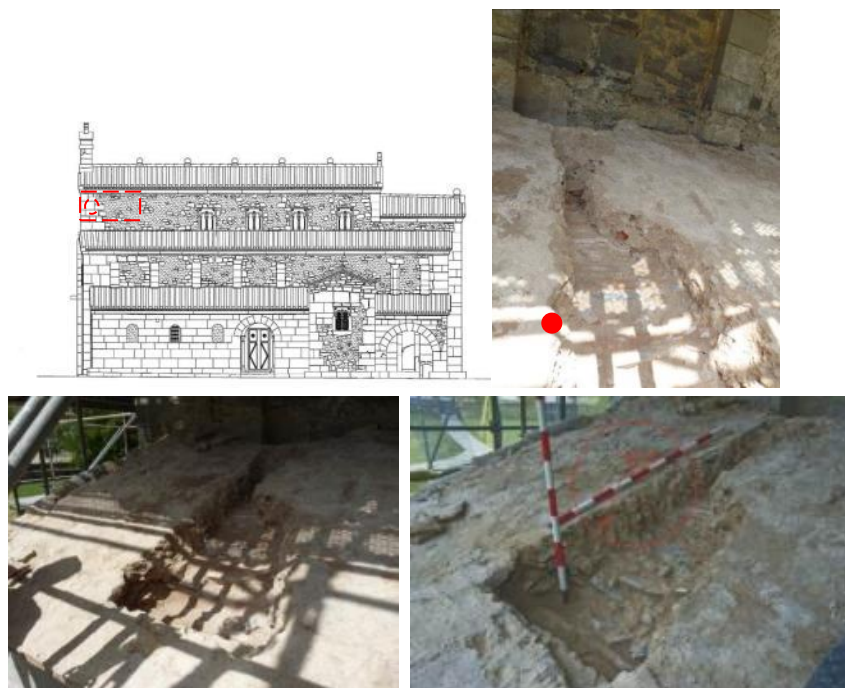
Figura 5.176.- Localización y aspecto «in situ» de la muestra de mortero M15/CV46.
