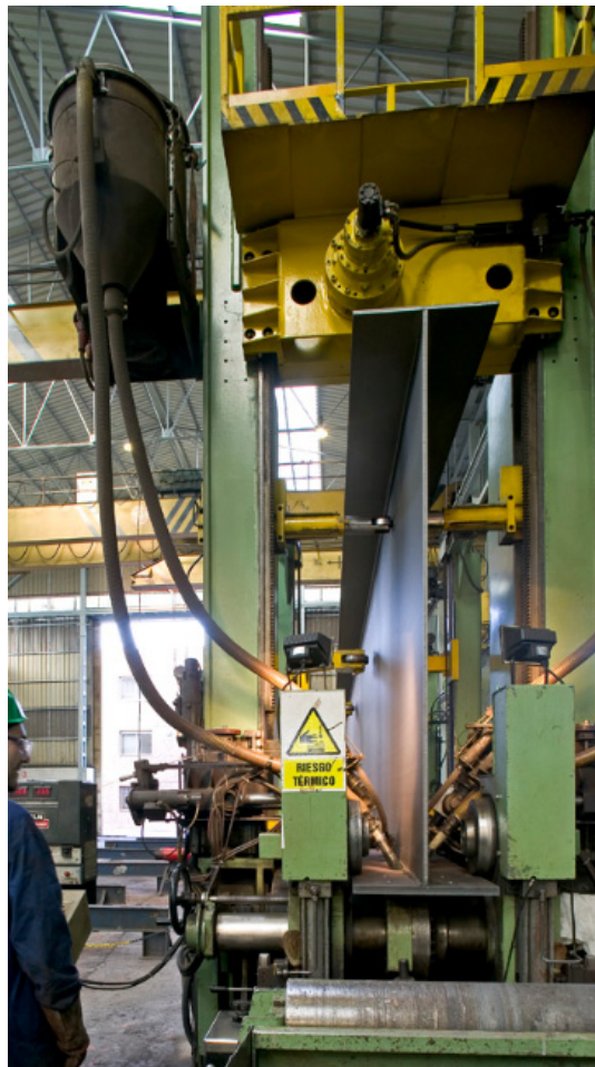
Figura 41. Soldadura de pieza en máquina de armado
