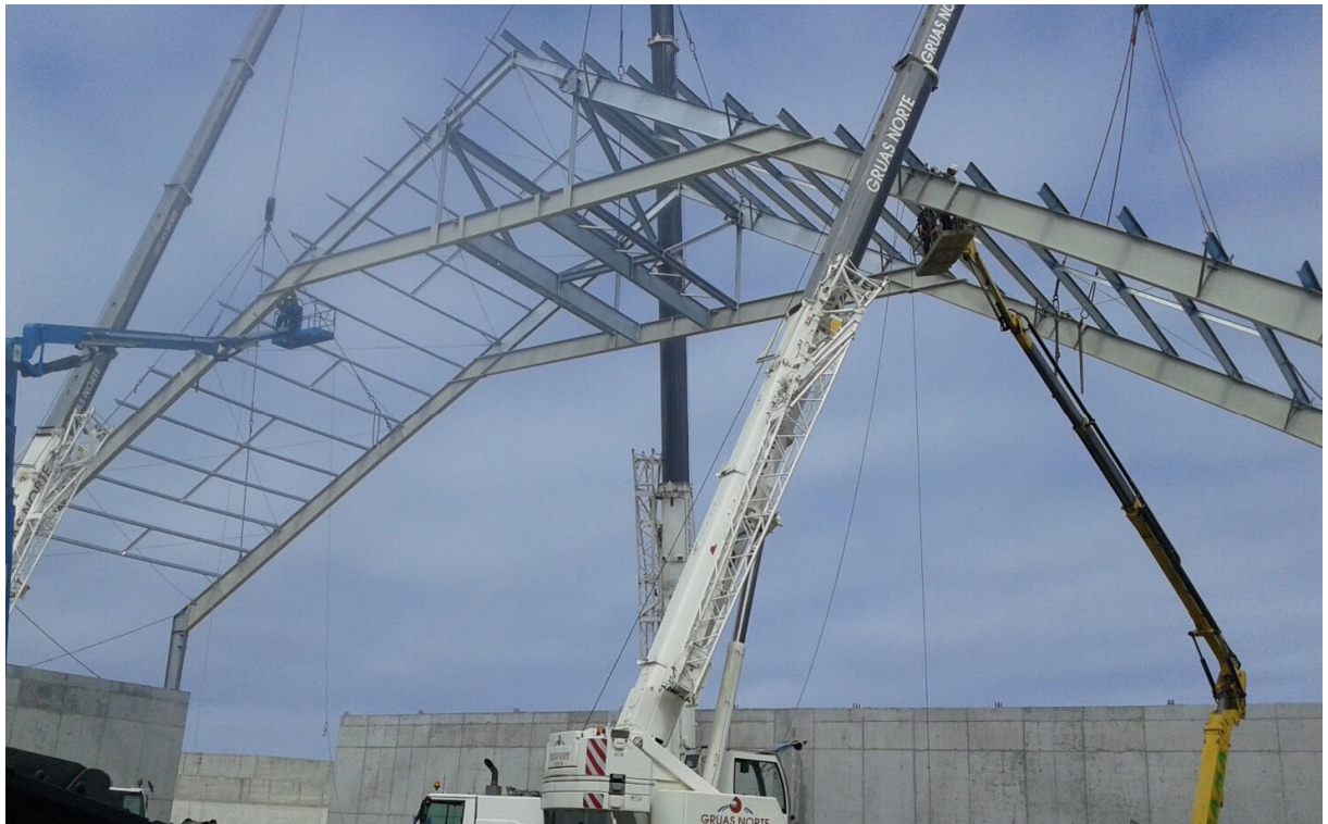
Figura 105. Montaje de pórtico armado con estructura para tripper
