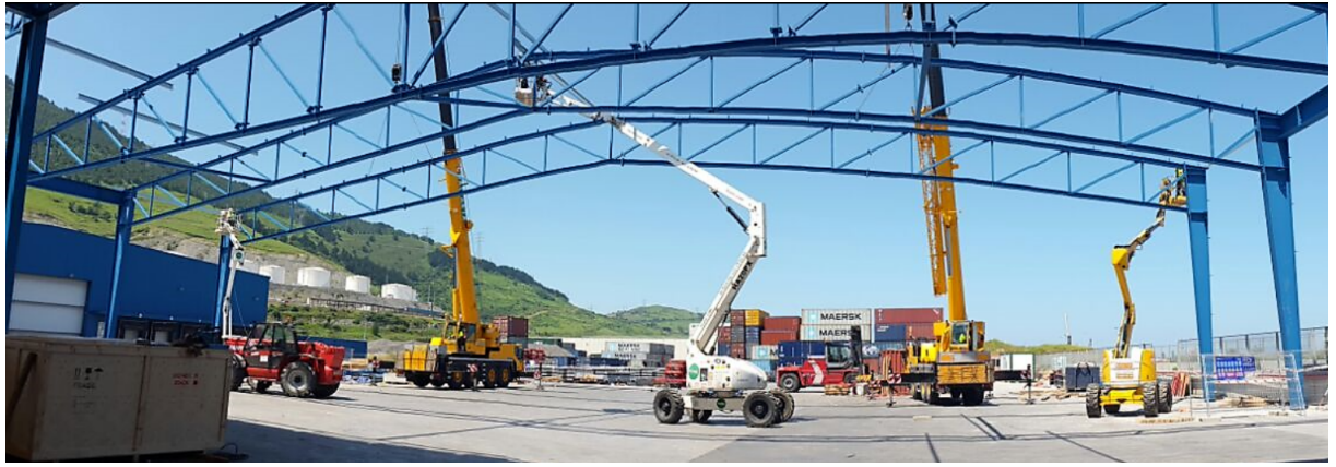
Figura 103. Montaje del pórtico con pilare armados y dintel en celosía
