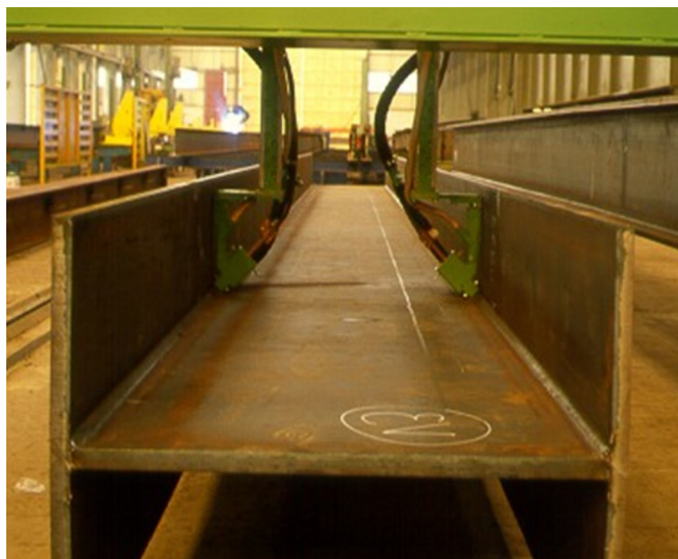
Figura 43. Soldadura con arco sumergido de viga armada
