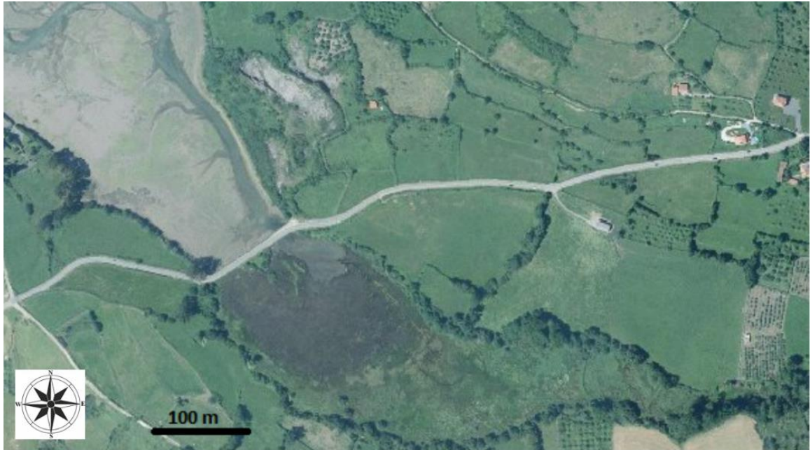
Figura 3.15 Aspecto de la ensenada en el año 2015. Se observa el neto contraste existente entre los terrenos ubicados a ambos lados de la carretera. Además se observa el alto grado de abandono de los terrenos ubicados en el interior de la ensenada, donde apenas se marcan los límites de las parcelas.
