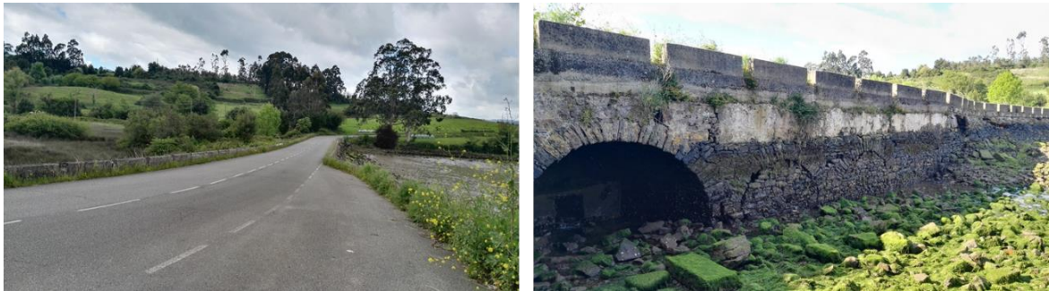
Figura 3.6 Carretera VV-6 (izquierda) situada sobre las compuertas clausuradas del antiguo molino (derecha).
