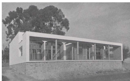
Foto 3. Fachada de la escuela del Preventorio de Arenys de Mar. Trías, 1937, Pág. 507.
