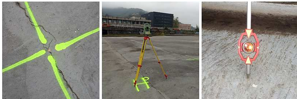
Figura 11: Herramientas utilizadas en el establecimiento de los puntos de control. La imagen izquierda muestra el clavo de uno de los puntos de control; la imagen central, la estación total en el punto de estacionamiento y la imagen derecha muestra el miniprisma utilizado, modelo GMP111
