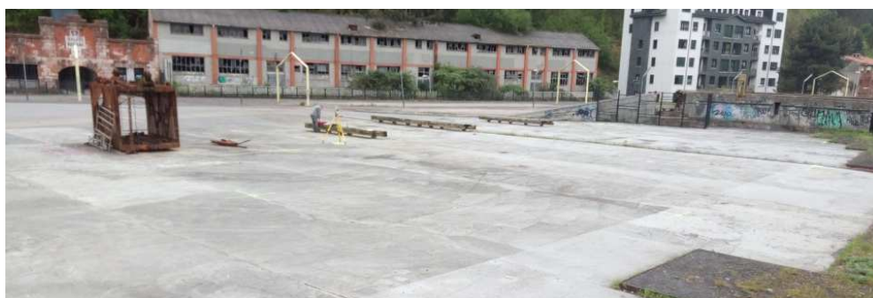
Figura 8: Área de estudio localizada en la bocamina del Socavón Barredo de la Mina Mariana (Mieres)
