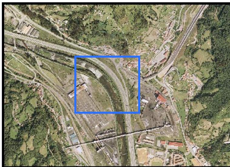
Ilustración 44. Ortofoto del Río Caudal antigua.
