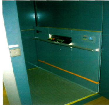
Cabina interior de ascensor con pasamanos y botonera accesible
