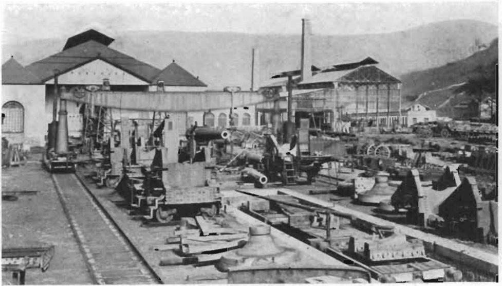
FÁBRICA NACIONAL DE TRUBIA. - VISTA DEL PARQUE CONSTRUCCIÓN DE MONTAJES.
