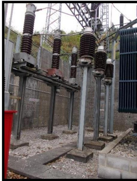
**Figura 4: Interruptores y transformadores de medida de SE Carrocera II**
