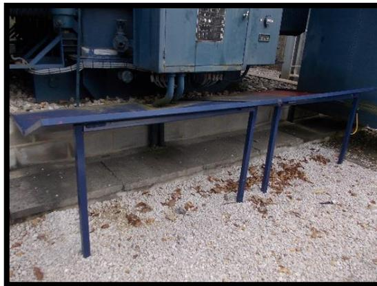
**Figura 60: Bandeja de derrames del depósito de expansión y cubeto**
