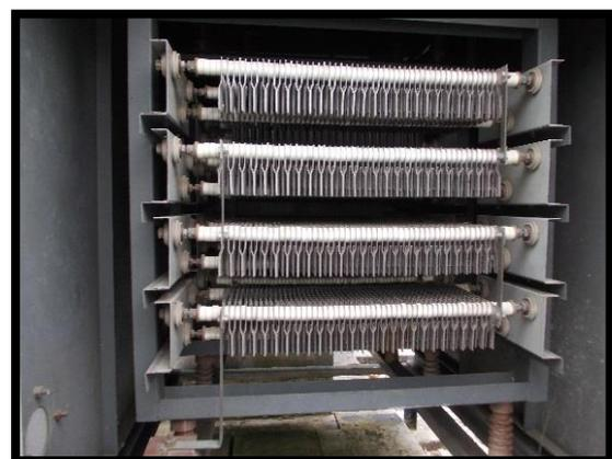
**Figura 51 : Controles del equipo y resistencias del neutro**
