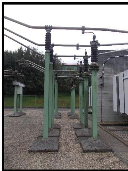
**Figura 62: Interruptores y transformadores de medida**
