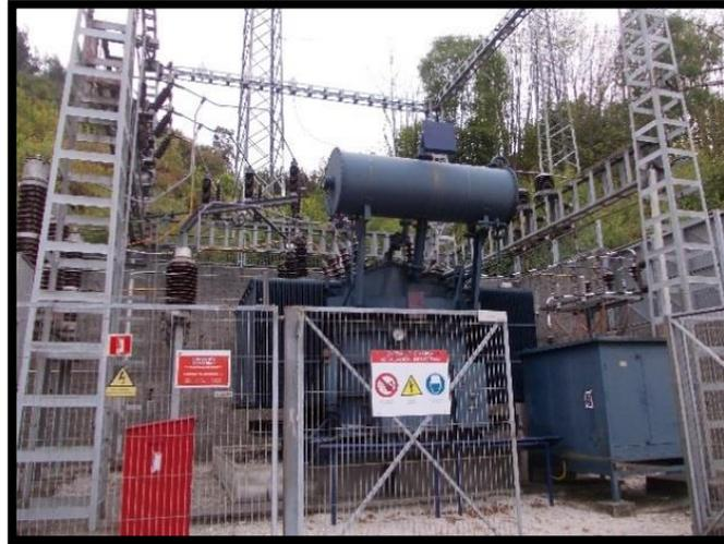
**Figura 3: Transformador de potencia de SE Carrocera II**
