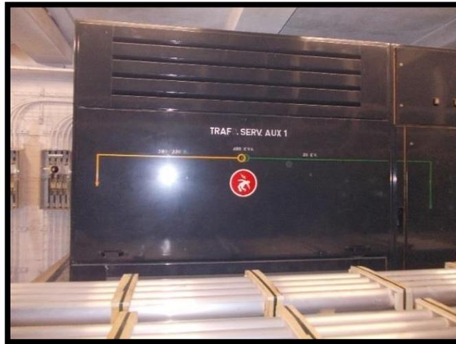
**Figura 24: Transformador de servicios auxiliares (seco) de SE Carrió**
