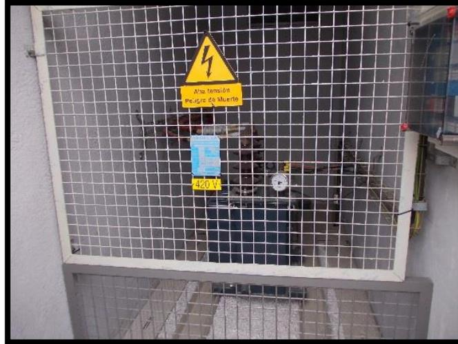
**Figura 13: Transformador de servicios auxiliares SE Pravia**
