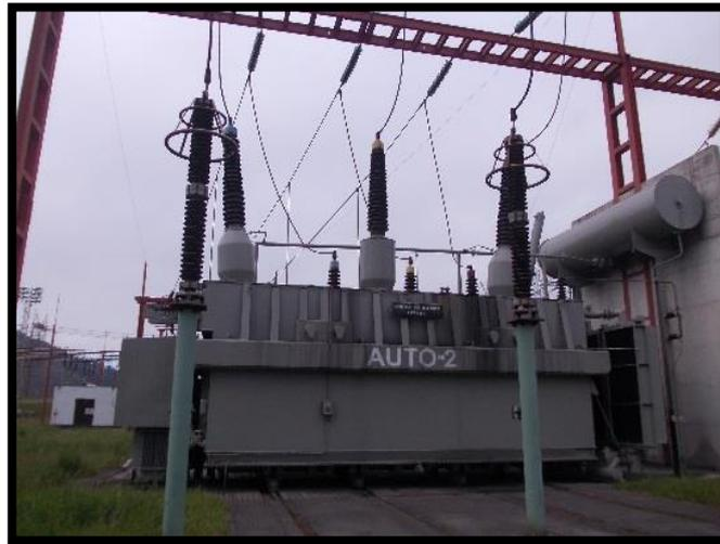
**Figura 18: Autotransformador 2 de SE Carrió**
