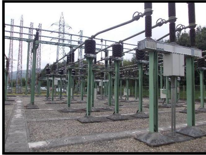
**Figura 11: Interruptores y seccionadores de SE Pravia**
