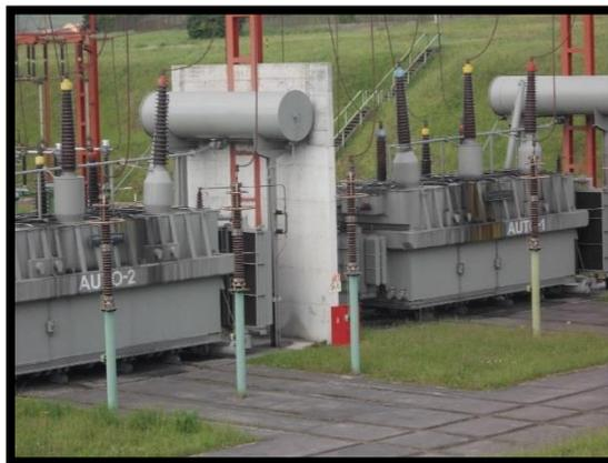
**Figura 54: Muro cortafuegos**
