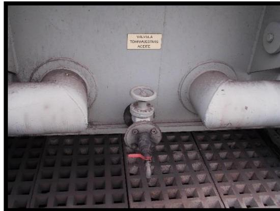
**Figura 68: Válvula de toma de muestras**
