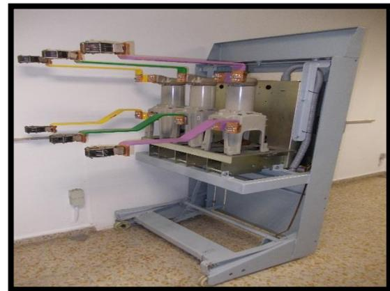
**Figura 65: Celdas de 20kV e interruptor**
