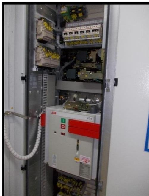
**Figura 23: Celdas de SF<sub>6</sub> de SE Carrió**
