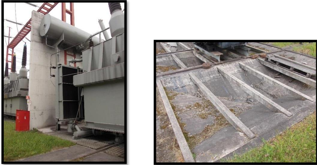
**Figura 61: Bandeja cortafuegos y cubeto del transformador**
