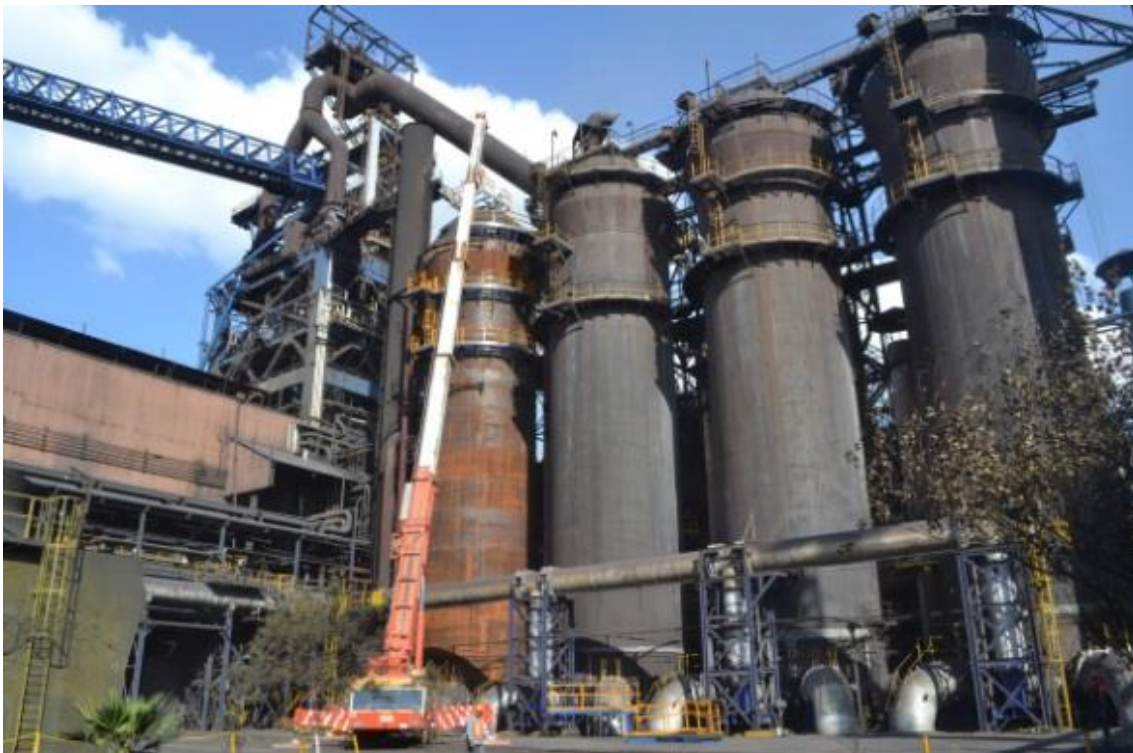
Ilustración 12: Estufas Cowper de un alto horno.
