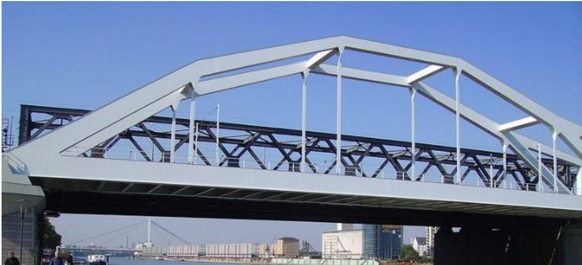
Ilustración 1: Puente de acero.
