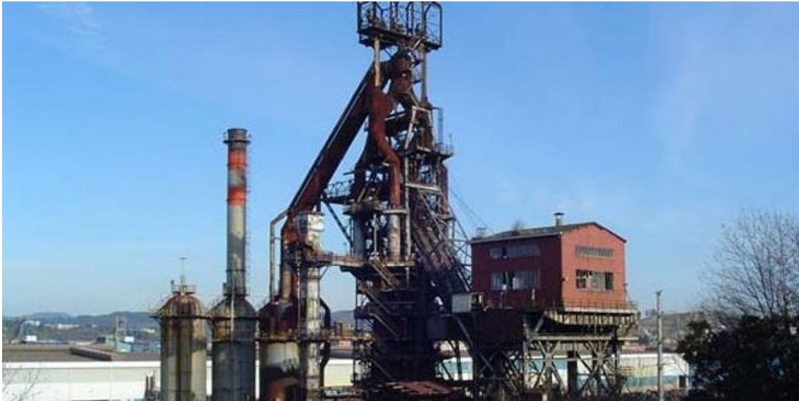
Ilustración 7: Instalación de horno alto.
