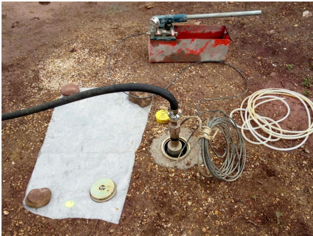
Figura 46.- Inyección en el sondeo IW2.
