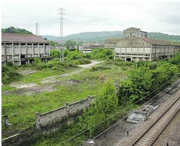
Figura 1.- Situación actual de abandono de las instalaciones. lne.es
