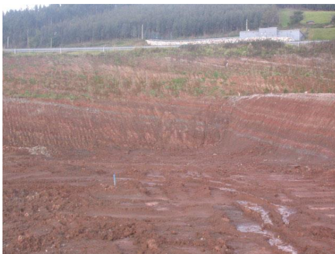
Figura 4 Foto de un talud triásico de la zona durante obras en el 2006.
