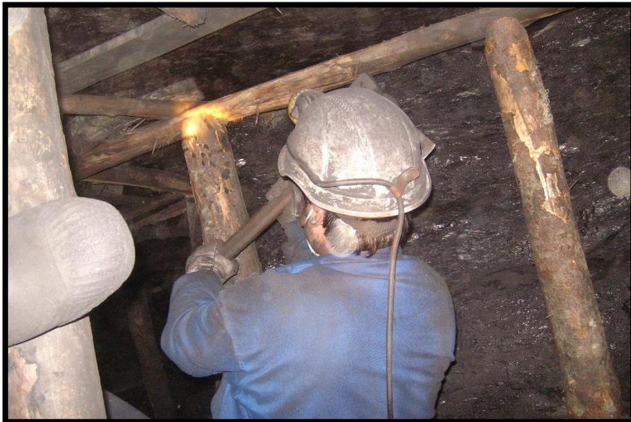
*Figura 16 Minero posteando la pieza cabeceada en el bastidor de techo
