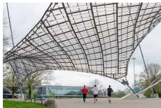
Figura 2.13 Estructura tensada del estadio olímpico de Munich, obra de Frei Otto, 1972. Fuente: Shutterstock. Disponible en: www.shutterstock.com/es/
