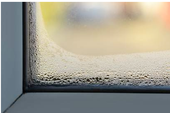
Figura 5.43 Condensación sobre la superficie interior de la ventana y aparato deshumidificador. Fuente: Shutterstock. Disponible en: www.shutterstock.com/es/
