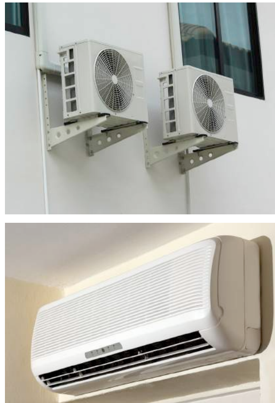
Figura 6.55 Unidad exterior e interior de sistema de aire acondicionado. Fuente: Shutterstock. Disponible en: www.shutterstock.com/es/
