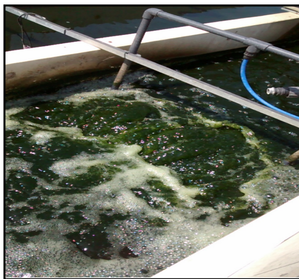
Figura 2. Detalle del foso del reactor
