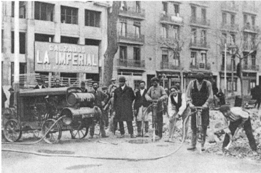
Fig. 6. Pavimentación del Paseo del Prado (Madrid, 1925). Fuente: FCC.
