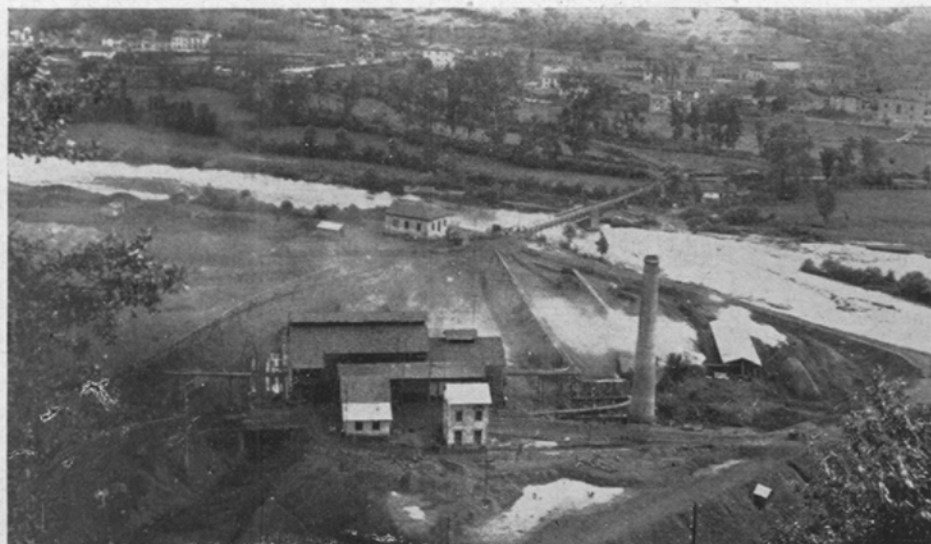
Vista general de los Lavaderos, canalización, oficinas y puente sobre el Nalón
