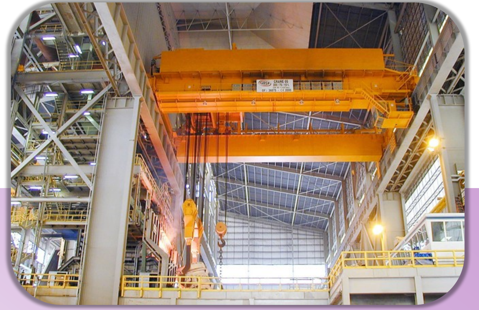
Imagen de la Grúa
