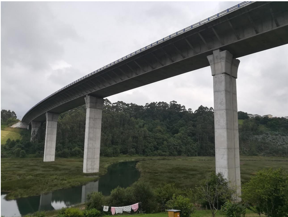
Ilustración 3.3.1. El viaducto del Meiro sobre los meandros del curso fluvial, observado desde Los Carballinos.
