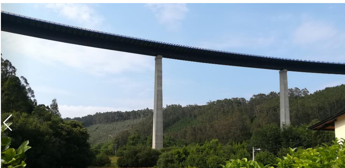
Ilustración 3.7.1. Viaducto de Canero observado desde la llanura de inundación que atraviesa.
