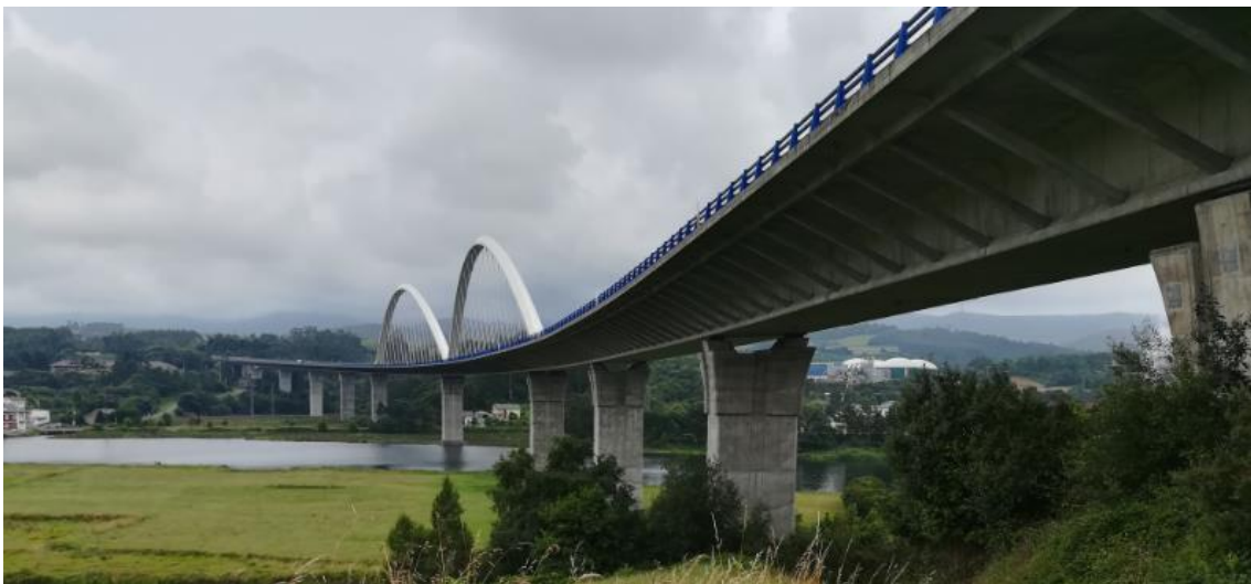
Ilustración 3.4.1. Viaducto del Navia observado desde sus pilares más occidentales.
