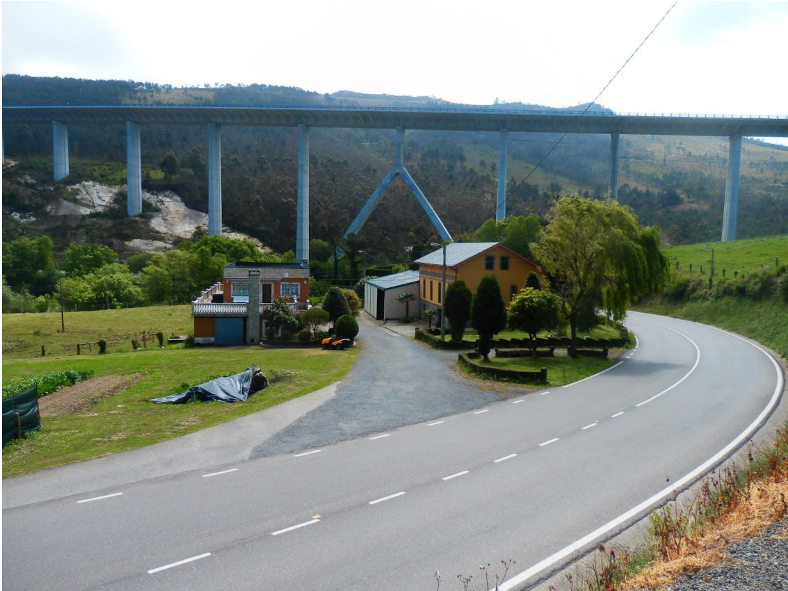
Ilustración 2.5. Viaducto de Barayo junto la población de El Bao, Navia. Fuente: http://xurdemorán.blogspot.com , 25/05/2018.
