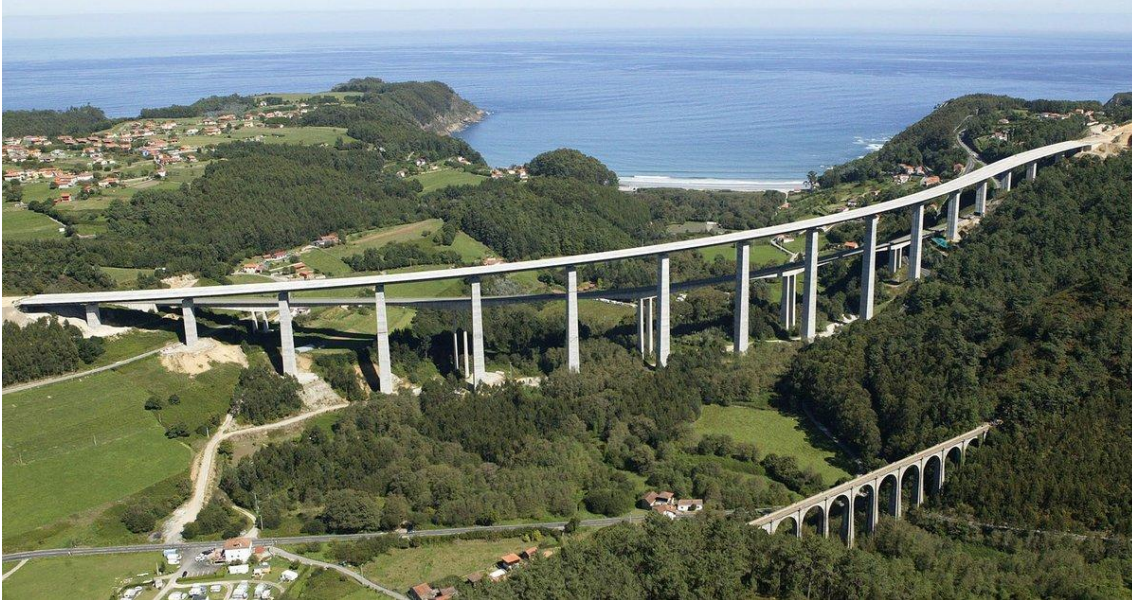
Ilustración 2.11. Vista aérea de los viaductos de Artedo. Fuente: Mapio.net, 25/05/2018.
