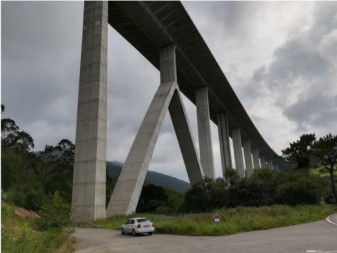
Ilustración 3.5.2. La grandiosa dimensión de los pilares que sustentan el viaducto de Barayo.
