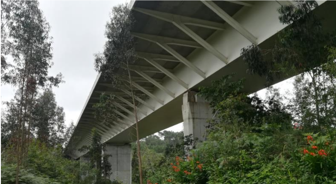
Ilustración 3.2.1. Viaducto de Porcía observado desde abajo.
