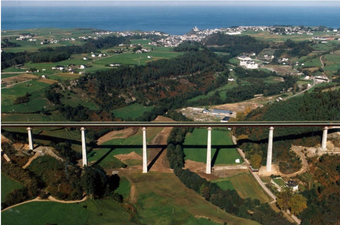
Ilustración 2.6. Vista aérea del viaducto de San Timoteo, con Luarca al fondo. Fuente: https://docplayer.es , 25/05/2018.
