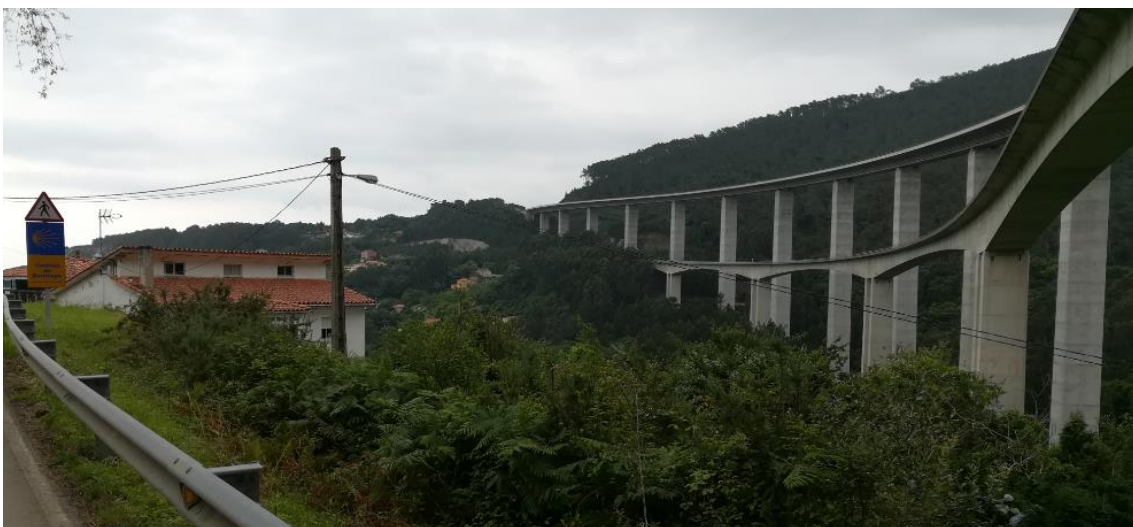
Ilustración 3.11.3. Señalización del Camino de Santiago junto a los viaductos de la Concha de Artedo.
