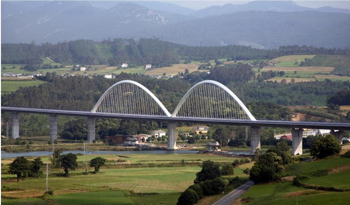
Ilustración 2.4. Viaducto de Navia, observado desde Coaña. Fuente: http://premiosconstrumat.com , 25/05/2018.
