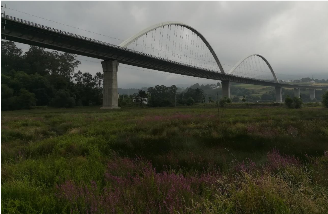
Ilustración 3.4.2. Vista del viaducto desde Las Aceñas, alzándose como telón de fondo detrás del paisaje del espacio de alto interés ecológico de los carrizales de las marismas del río Anleo.
