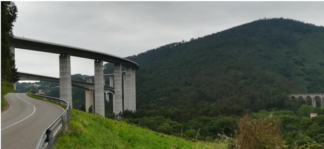
Ilustración 3.11.2. Los tres viaductos de Artedo.
