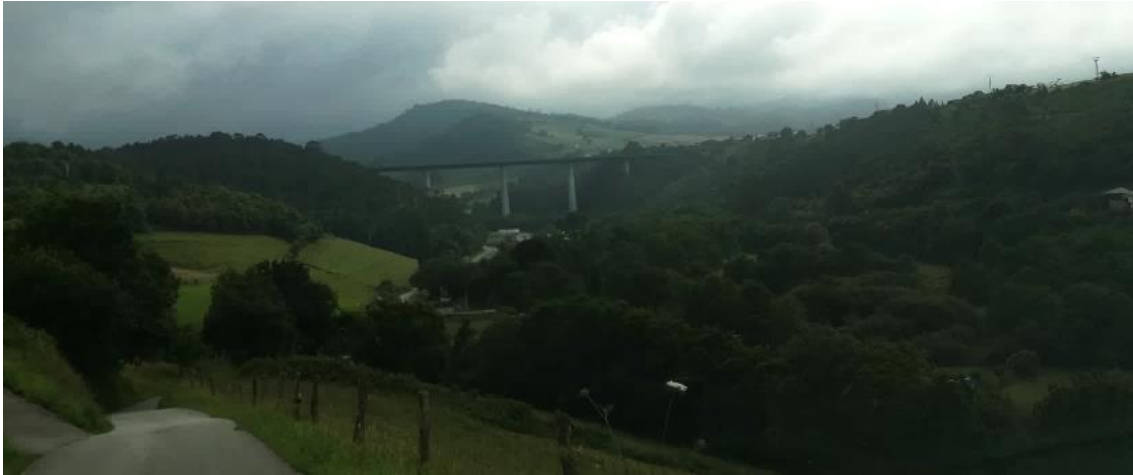
Ilustración 3.6.1. Viaducto de San Timoteo observado desde Almuña.
