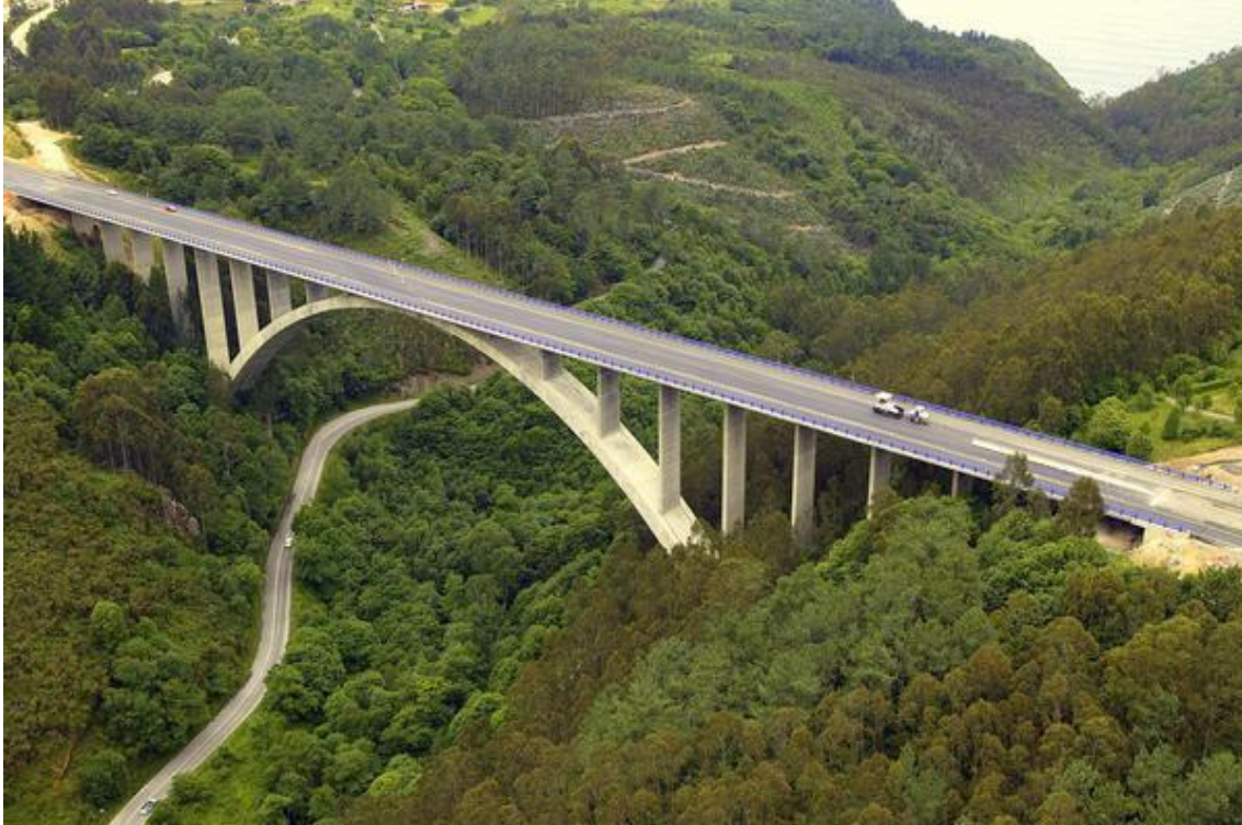
Ilustración 2.8. Vista aérea del viaducto de Pintor Fierros. Fuente: Antonio Navarro Manso, 28/06/2007.
