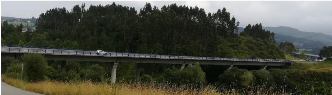
Ilustración 1.1. Viaducto del arroyo Remolinos, de 197 metros, anterior al viaducto del Nalón circulando en sentido este, el cual ya se vislumbra a la derecha de la imagen.
