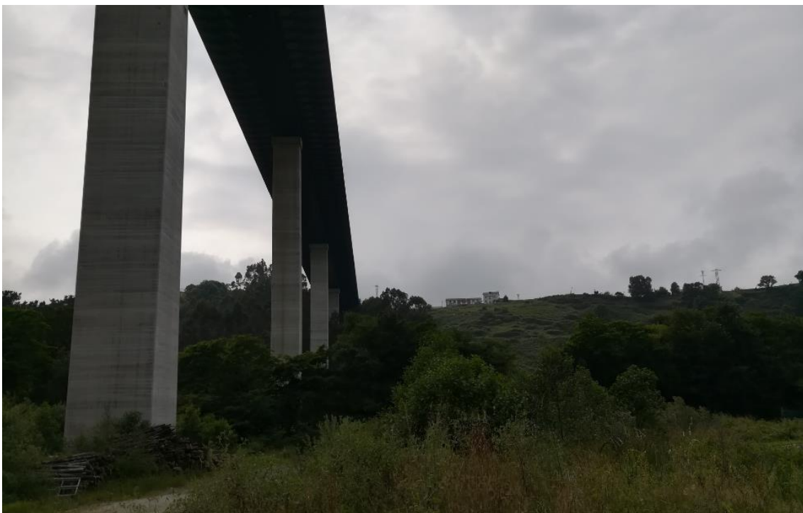
Ilustración 3.6.2. Pie del viaducto de San Timoteo, desde el cual se aprecian viviendas en las proximidades del núcleo de Setienes.
