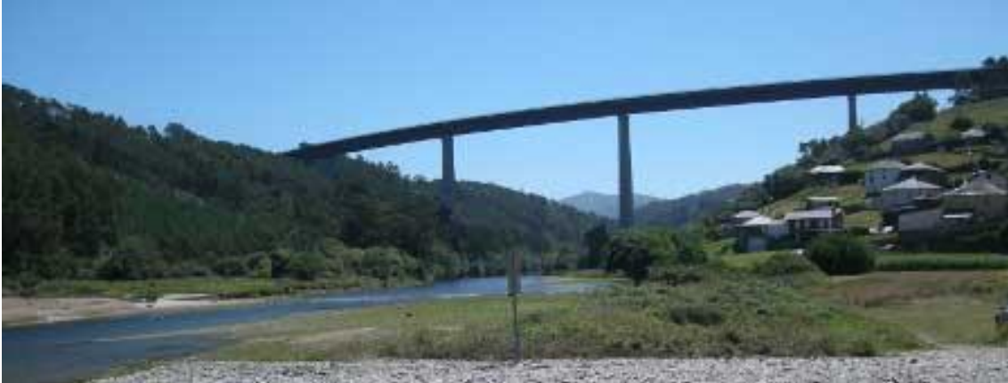
Ilustración 2.7. Viaducto de Canero y población de Cueva, observados desde la playa de La Arena. Fuente: http://www.senderismoenasturias.es/ , 25/05/2018.
