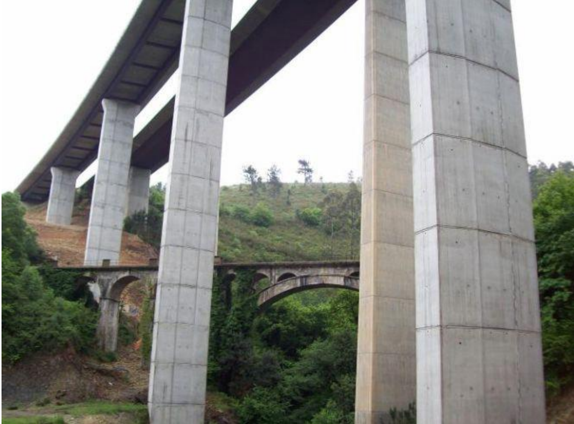
Ilustración 2.9. Viaductos de Lindabarcas. Fuente: pondio.com, 25/05/2018.
