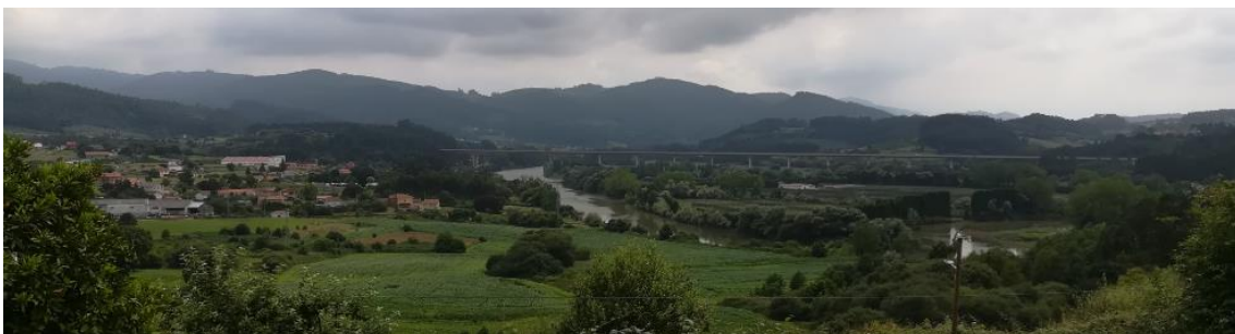
Ilustración 3.12.1. Vista del viaducto del Nalón desde Soto del Barco.
